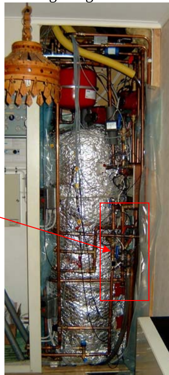
Figur 3.6 Installation av den nya ackumulatortanken på den gamla el-vattenvärmarens plats.
