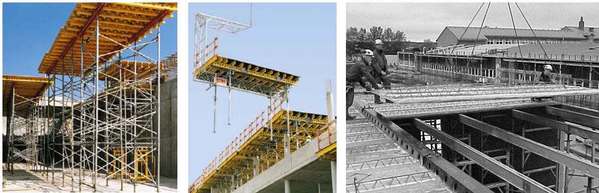
Figur 2. (a) & (b) Exempel på traditionell form (från PERI). (c) Exempel på kvarsittande formsystem, plattbärlag.
