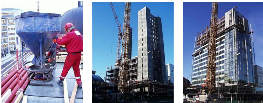
Figur 8. Fyllning av fyravåningshöga samverkanspelare samt olika stadier av byggprocessen i projektet Sørkedalsveien 6 (foto NCC Norge).
