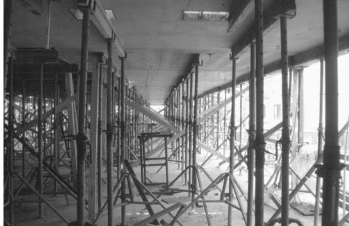
Figur 3. Hur det kan se ut på en arbetsplats, stämning av bjälklag.
