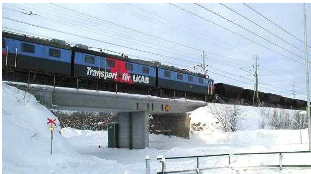
Figur 5.5 Järnvägsbro av armerad betong. Loussajokk-bron i Kiruna.
