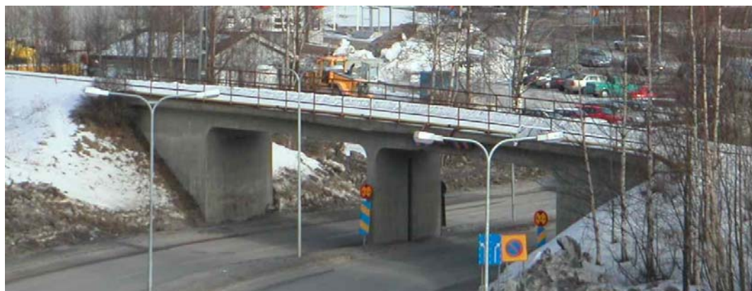
Figur 5.35 Foto av bron taget från Norra sidan ca 1 år innan provningen genomfördes
