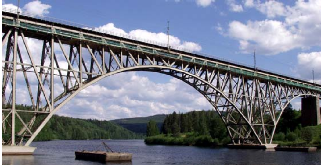
Figur 5.6 Järnvägsbro av nitade stålprofiler. Forsmobron.
