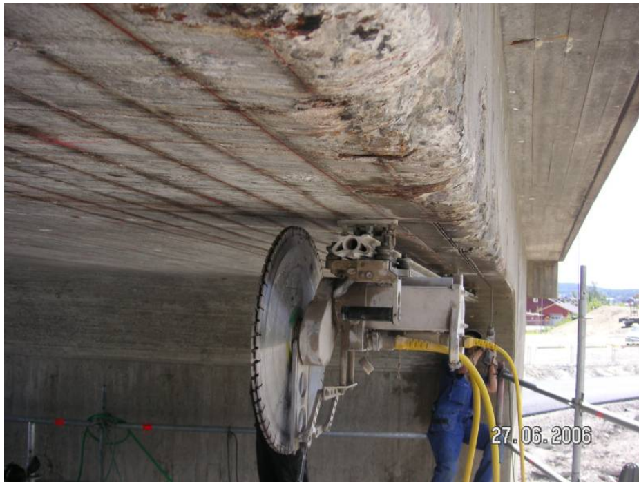
Figur 5.40 Sågning av spår för NSMR stavar
