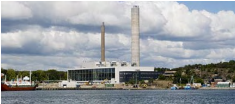
Figur 2.1 Rya KVV med utsikt över Göta Älv ( www.goteborgenergi.se )
