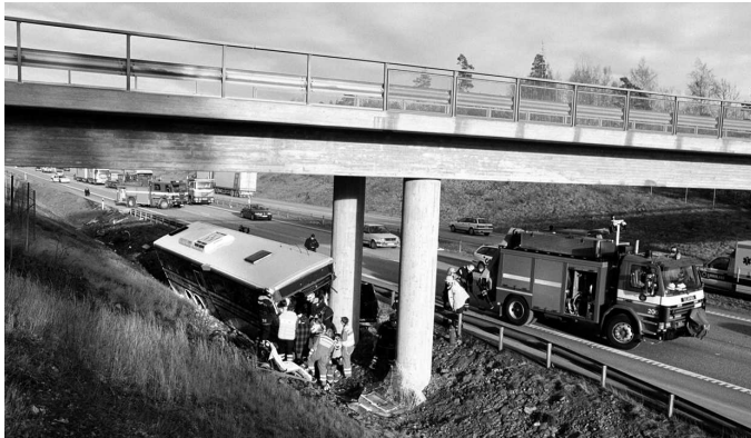
Figur 21 Konsekvens av att inte stänga "räckesfönster" (Vägverket, info om räcken, hemsida)
