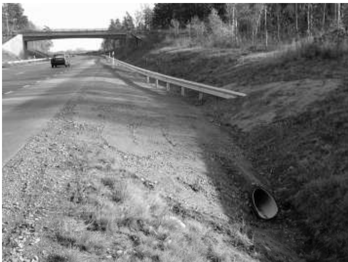
Figur 20 Utböjd räckesavslutning (Vägverket, info om räcken, hemsida)
