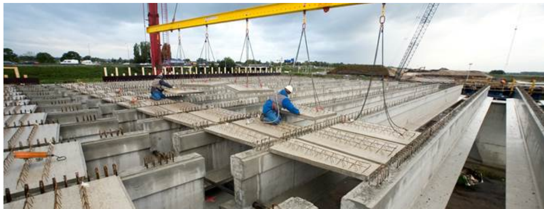
Figur 9. Montering av prefabricerade betongplattor, från Q. Kees (personlig kommunikation, 27 mars 2019) Återgiven med tillstånd.
