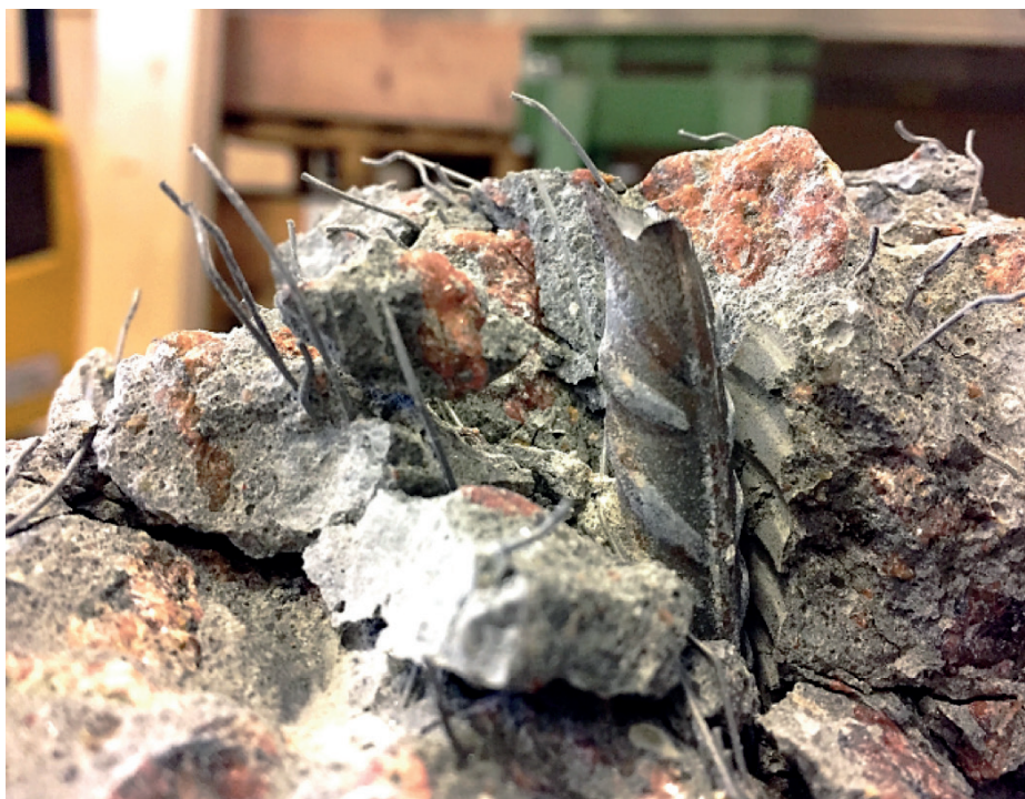
Figur 1: Exempel på en avsliten armeringsstång ingjuten i fiberarmerad betong.
