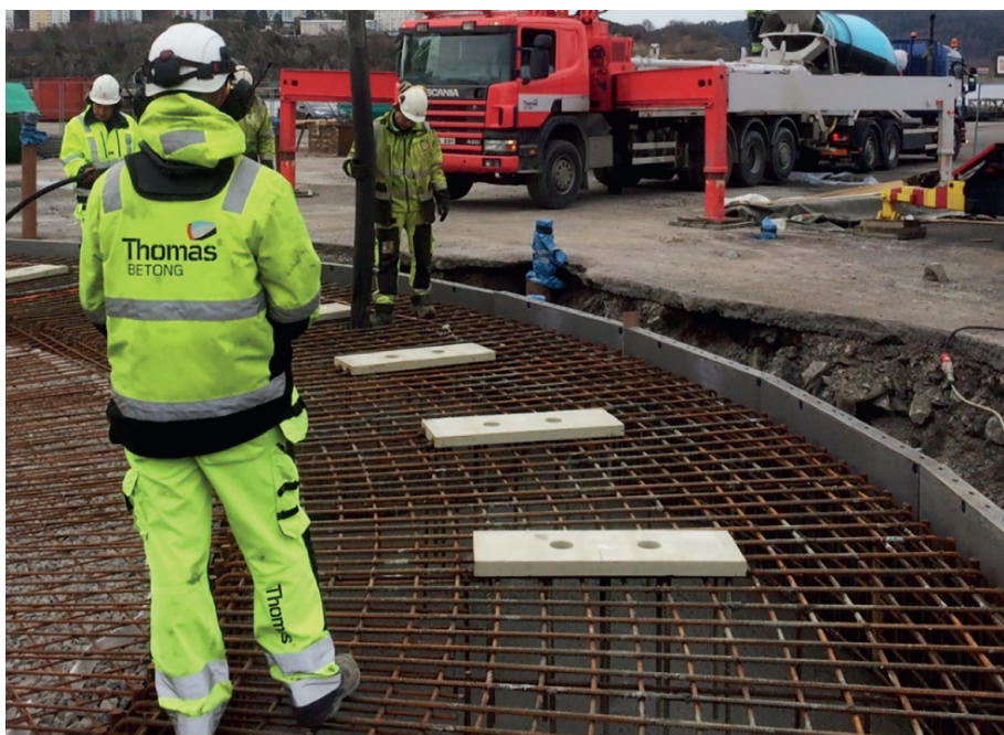
Figur 1: Fullskalegjutning av fundament till silo i Uddevalla hamn.
