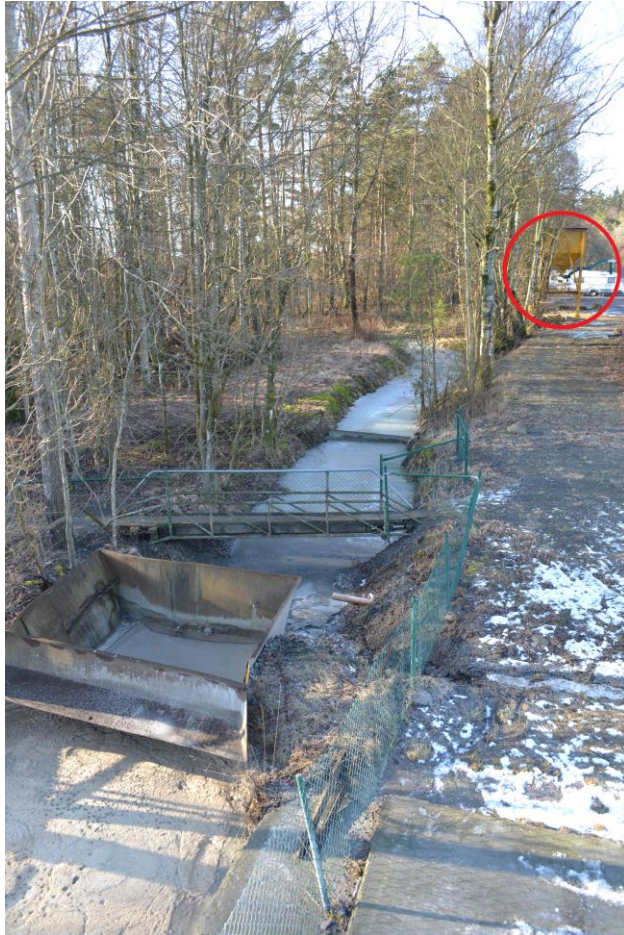
Figur 3. De olika sedimenteringsstegen, vattentank markerad i höger hörn. (Isaksson, Nilsson, 2016).
