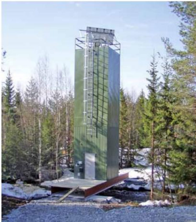
Figur 11. Kalkdosare (Vennman., 2010). Återges med tillstånd.
