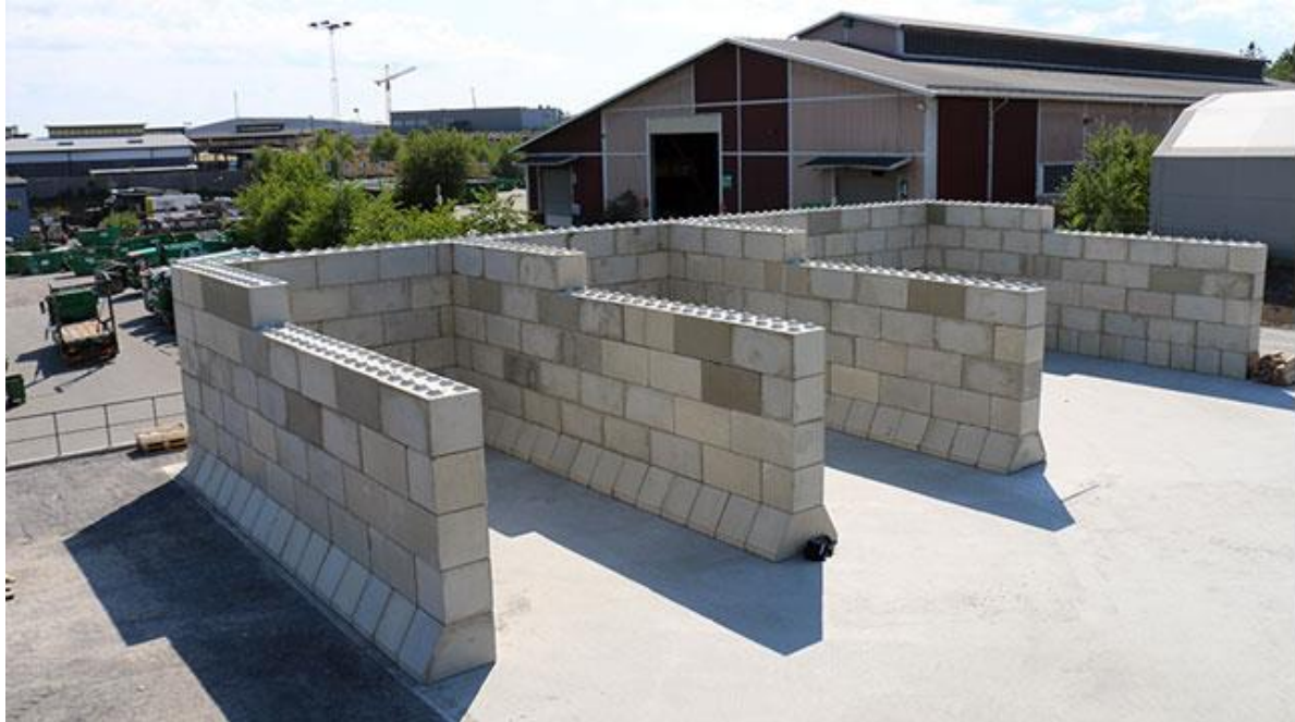
Figur 12. Betongblockskonstruktion (C3C, 2016). Återges med tillstånd
