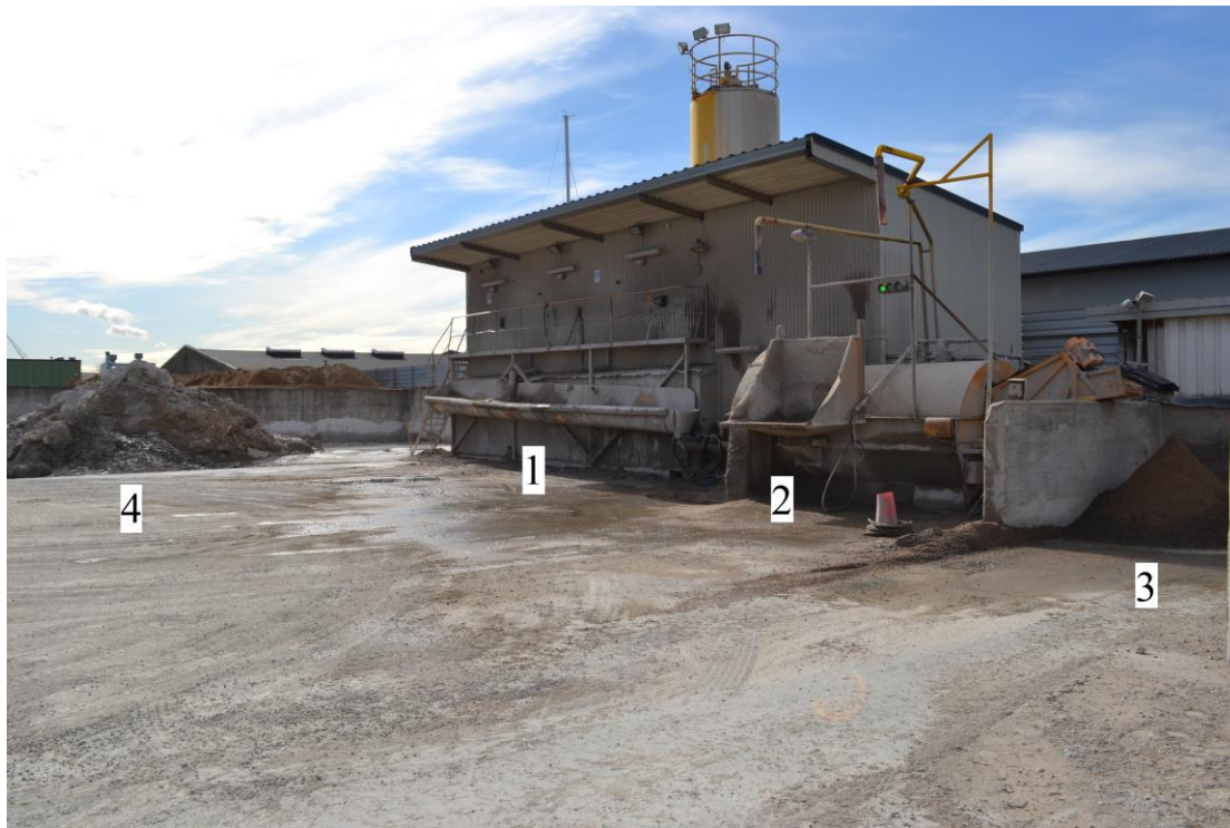
Figur 1. Ringöns restbetongsanläggning. (Isaksson, Nilsson, 2016).
