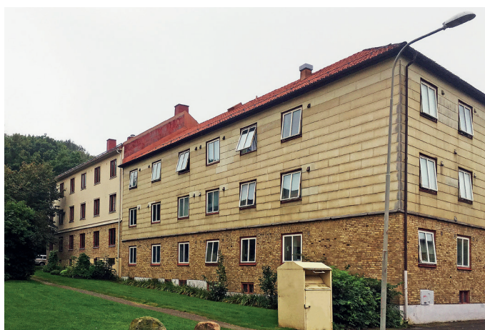
Figur 6: Fönsterbyte i ett landshövdingehus på Östra Stillestorpsgatan i Göteborg [10].
