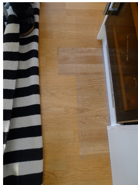
Lagad parkett där väggen med kyl- och frysen stod
