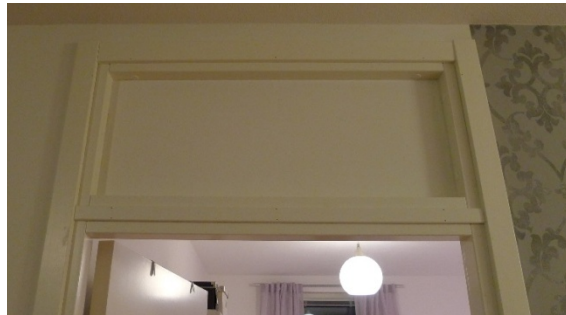
Förstorat gästrum och igensatt överljus
