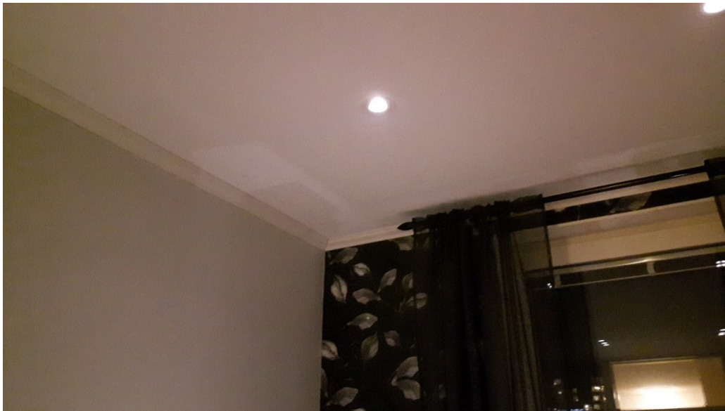
Innertak med infällda spotlights och taklister uppsatta för att få bättre ljudmiljö
