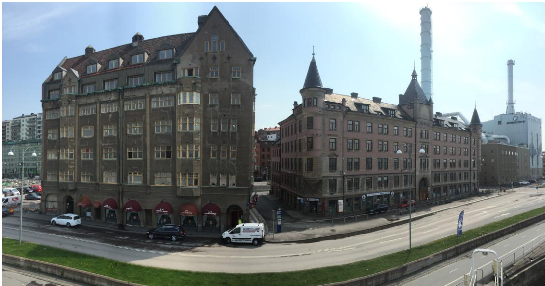
Bild 8. Kinesiska Muren, fasad mot älven. Merkurhuset till höger. Författarnas egen bild.
