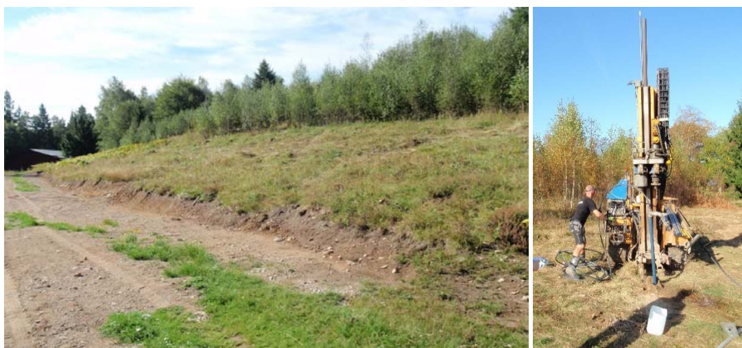
Figur 4.2 Sluttning mot Grinnerödssjön (fotot taget från nordost med sjön i ryggen) där fältförsöket genomfördes (t.v.) samt installation av observationsrör (t.h.).
