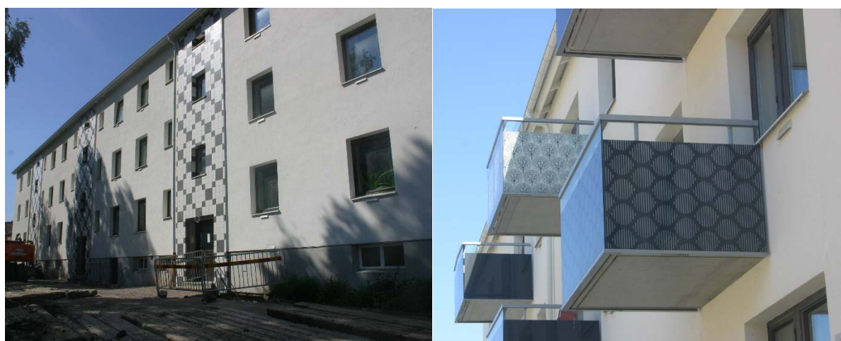
Bild 9: Husen har fått nya, putsade fasader, utsmyckningar med kakelplattor kring entréerna och trapphusen (vänster), något större balkonger samt nya balkongskärmar i glas med tryckta mönster (höger). Foto: Liane Thuvander
