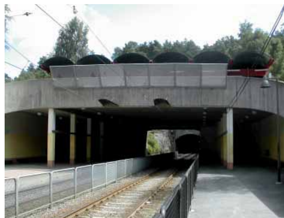
Spårvagnstunnel, Teleskopgatan. Hållplatsläget låg tidigare inne i tunnelmynningen
