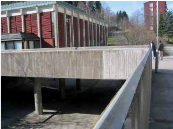
Gång under Rymdtorget där spårvagnen ursprungligen skulle ha fått sin sträckning
