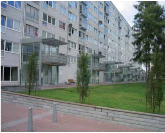
Nya genomgående entréer, östra Gårdsten
