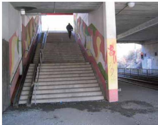
Trappa vid spårvagnshållplats
