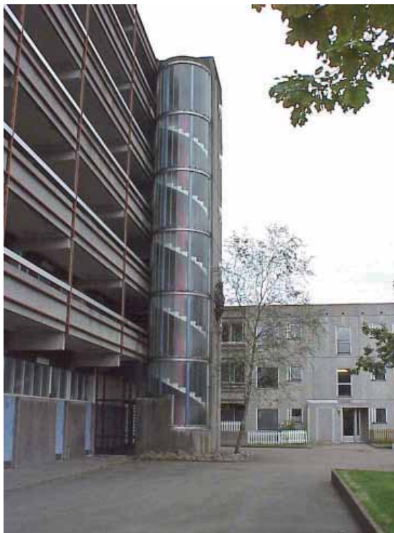
Trapphus före ombyggnad. Foto Eva Löfgren, Bebyggelseregistret, RAÄ
