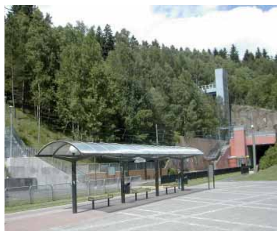
Rymdtorgets spårvagnshållplats efter upprustning
