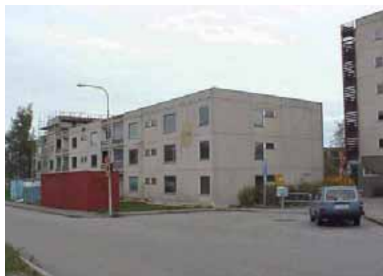
Bostadshus i västra Gårdsten före ombyggnad. Foto Per-Ola Åström, Bebyggelseregistret, RAÄ
