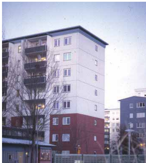
Norsborg, Stockholm. Efter ombyggnad
