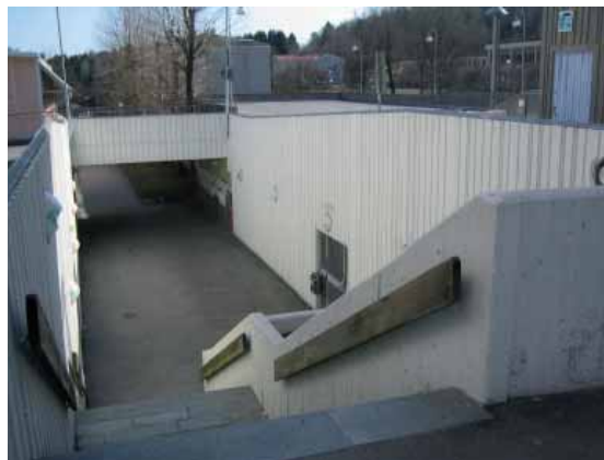
Gångväg och trappa, Rymdtorget
