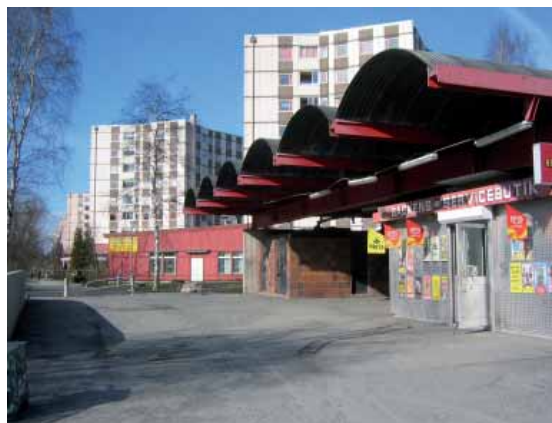
Teleskopgatans hållplatsbyggnad med för Bergsjöns karakteristiskt skärmtak
