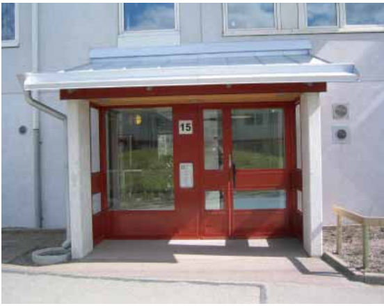
Ombyggd entré, östra Gårdsten
