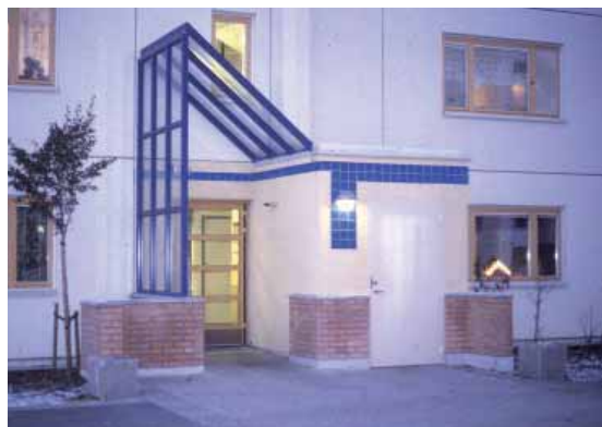
Norsborg, Stockholm. Efter ombyggnad
