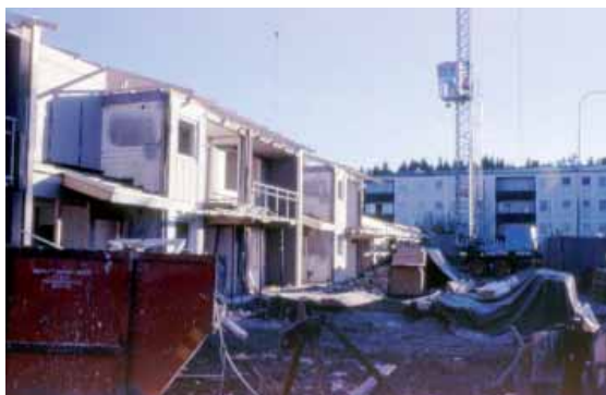
Stjärnbildsgatan i Bergsjön, Göteborg. Husen monterades delvis ner och byggdes om till radhus på 1980-talet. Foto Solveig Schulz
