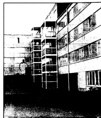
Provtrapphuset på Pennygången visar hur det ser ut när husen får en extra våning och alla lägenheter får balkong
