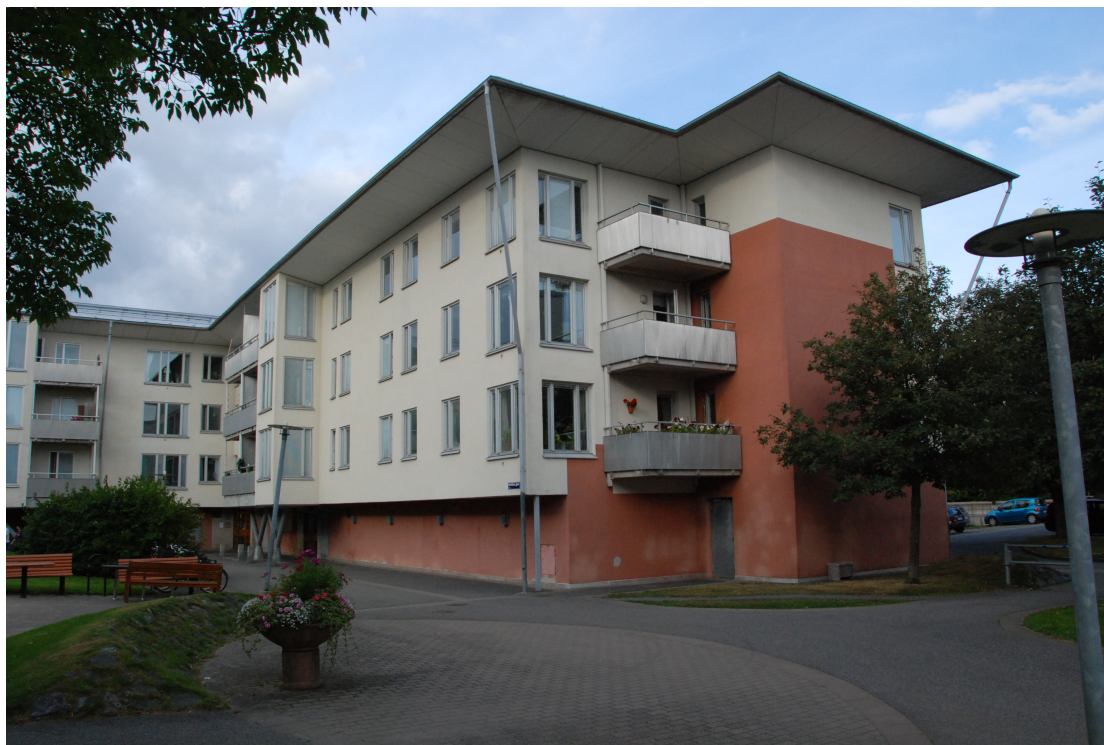
Figur 15: Fredrikas Gård, Gert Wingårdh klart 1997. Byggnaden har stora fönster som enligt anteckningar från tiden var dyra att genomföra. Foto. Paula Femenías
