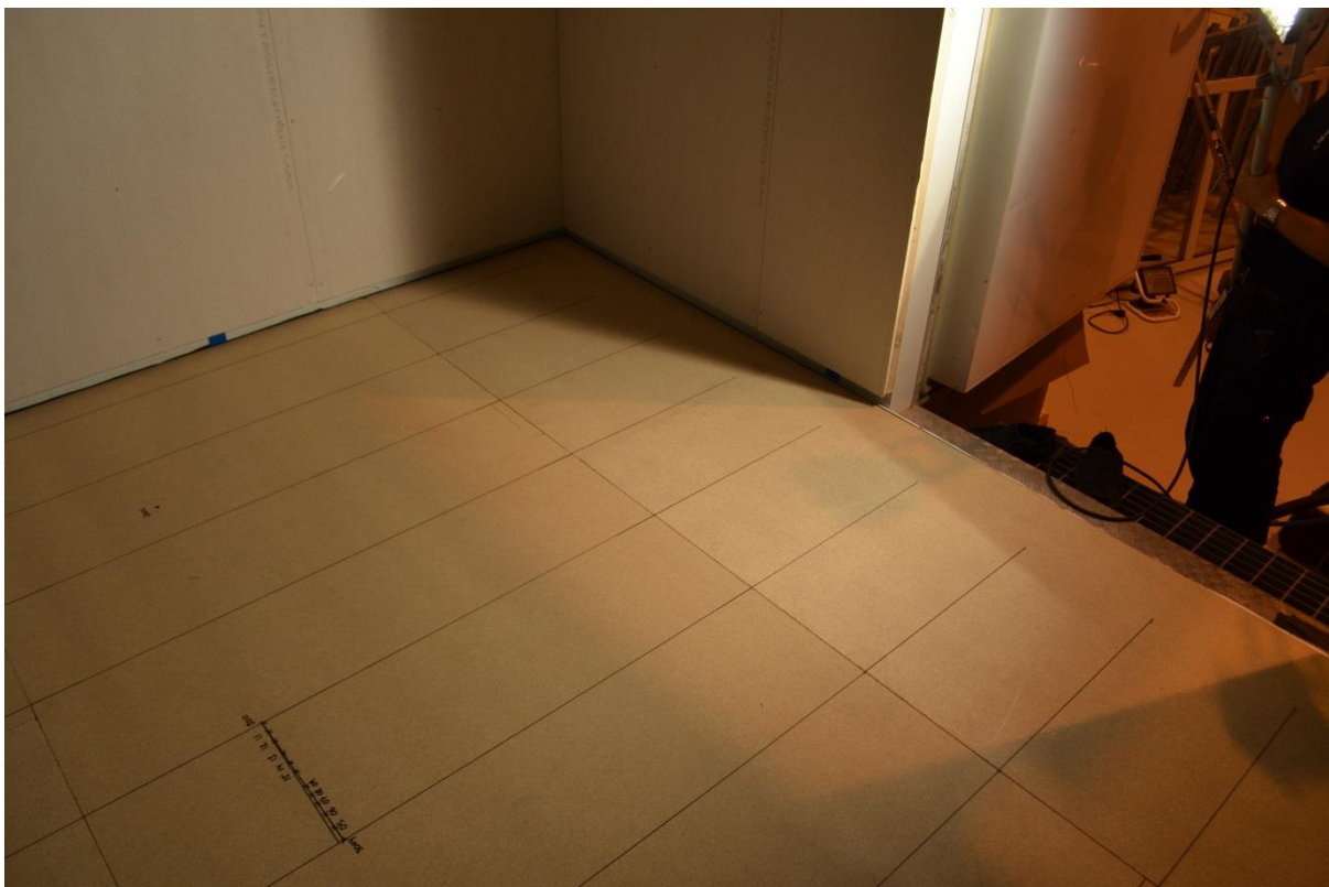
Figur 18 Färdigt golv - 12mm spånskiva.
