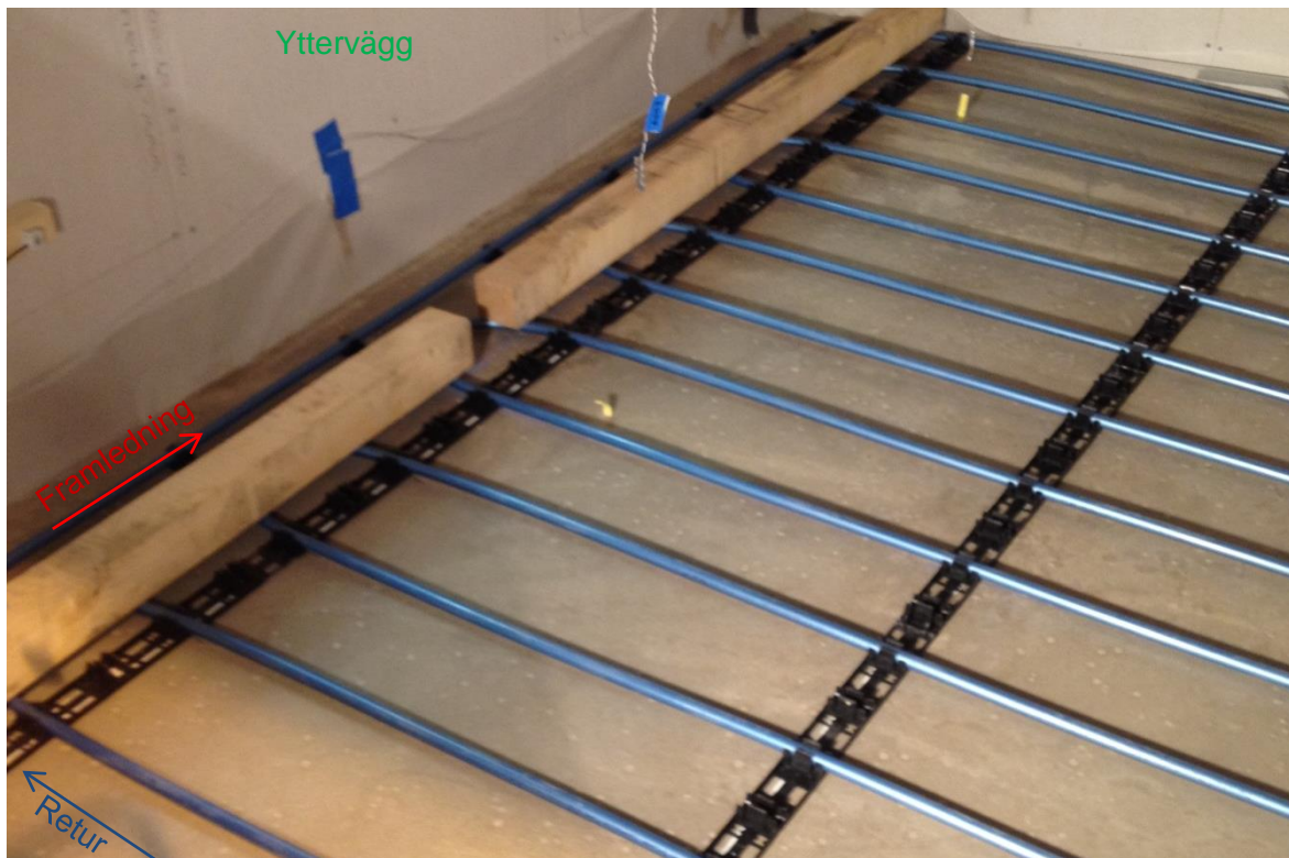
Figur 22 Inför gjutning av det 4:e och sista lagret i plattan. Bilden visar serpentinförläggningen av det ytliga CC200 systemet. Träreglarna håller endast nere böjarna under (del)gjutning så att PEX-röret ligger fixerat.
