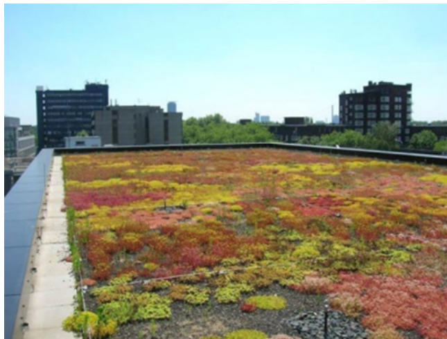
Figur 2.13: Sedumtak i Düsseldorf, Tyskland (Holzmüller, 2009).
