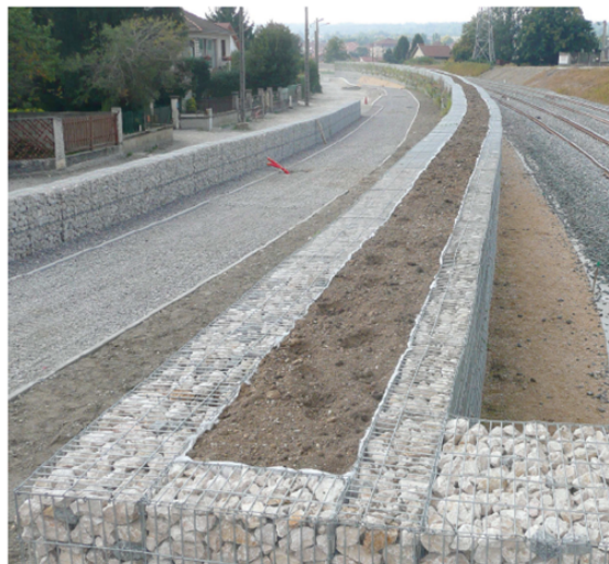
Figur 2.14: Låg bullerskärm försedd med jord som ger möjlighet för växtlighet (Defrance, 2013b).
