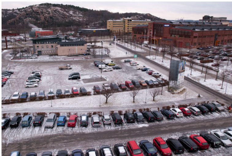
Figur 1.1: Område för byggnation, med Lindholmsallén i bakgrunden och Götaverksgatan till höger.
