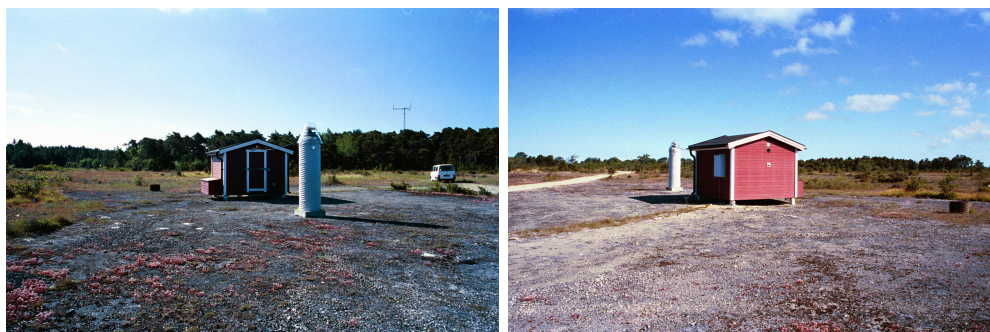
Figur 3.1: Visbystationen - Till vänster ses Visbystationen från norr och till höger ses den från söder. Notera den plana och öppna omgivningen kring stationen [23].
