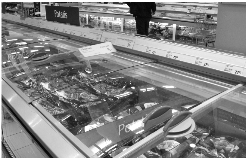
Figur 21. Lock på kyl- och frysdiskar gör att tillgången på spillvärme minskar i och med att förlusterna begränsas.
