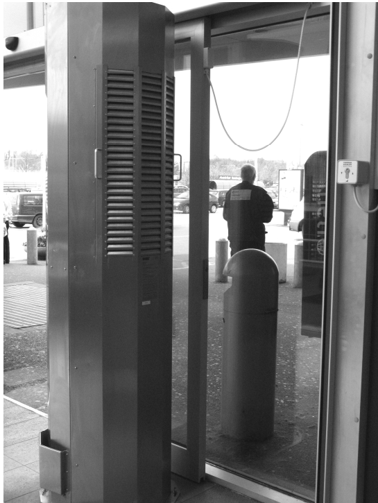
Figur 3. Ett exempel på intern värmeåtervinning i form av en varmluftsridå vid entrén. Bilden är tagen vid Coop Bäckebo.
