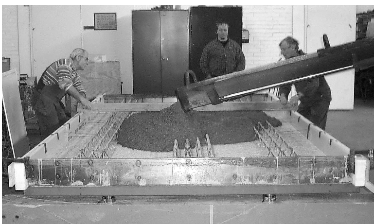
Figur 3.1 Utläggning av betongen vid pågjutning av plattbärlaget, foto Ingemar Löfgren.
