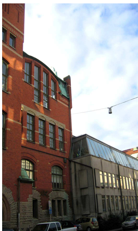
Figur 4-1 HDK-huset mot Teatergatan
