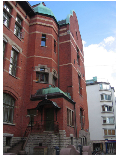
Figur 4-3 Tegelfasad mot söder.
