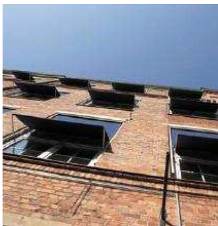
Figur 7-4 Utvändig solavskärmning.
