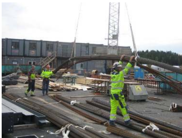
Figur 4.1 Leverans av armering i lagerlängder till byggarbetsplats.
