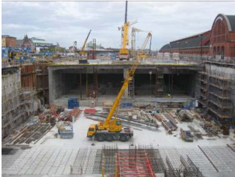
Figur 6.1 Konstruktionens utformning. Foto: Perry Nordeng, redigerad bild.
