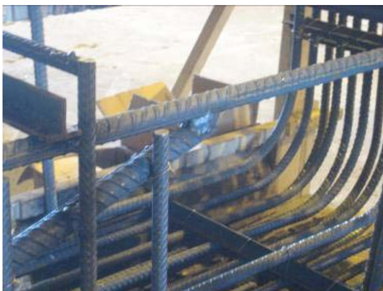
Figur 6.8 Svetsad monteringsarmering och najad armering vid montering i jiggen.
