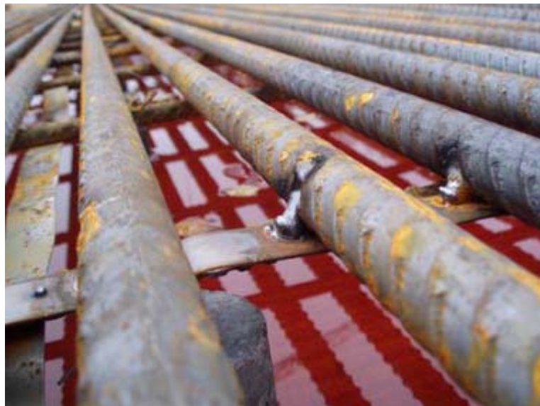
Figur 4.4 Fixering av armering till stålband. Bild från Kjellström & Nordmark.
