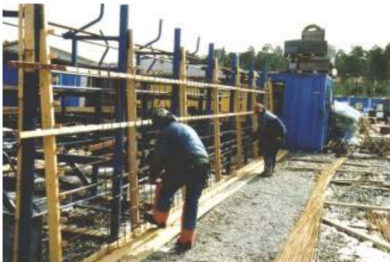
Figur 5.5 Exempel på armeringsstation för montering utrustad med jigg. Bild från NCC (2007).
