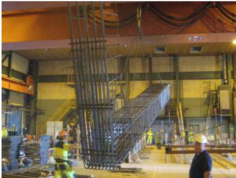
Figur 4.7 Förtillverkad armeringskorg lyfts ut ur fabrik för vidare transport.
