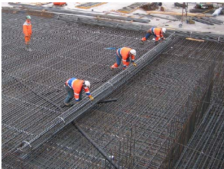
Figur 4.5 Utrullning av rullarmering. Bild från Celsa Steel Service.
