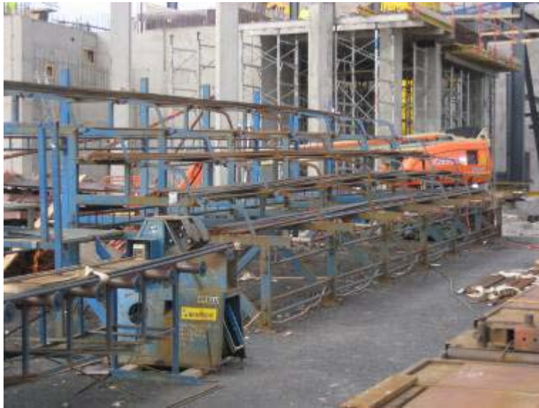
Figur 6.13 Del av armeringsstation vid Lillesjöverket med förlager och klippbänk.
