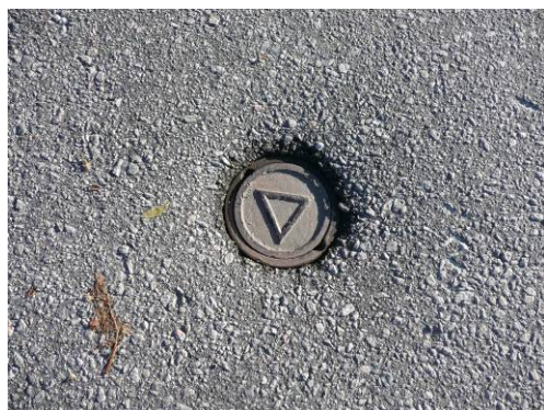
Figur 5.1 Kontrollpunkt för sättningar i villaområdet.
