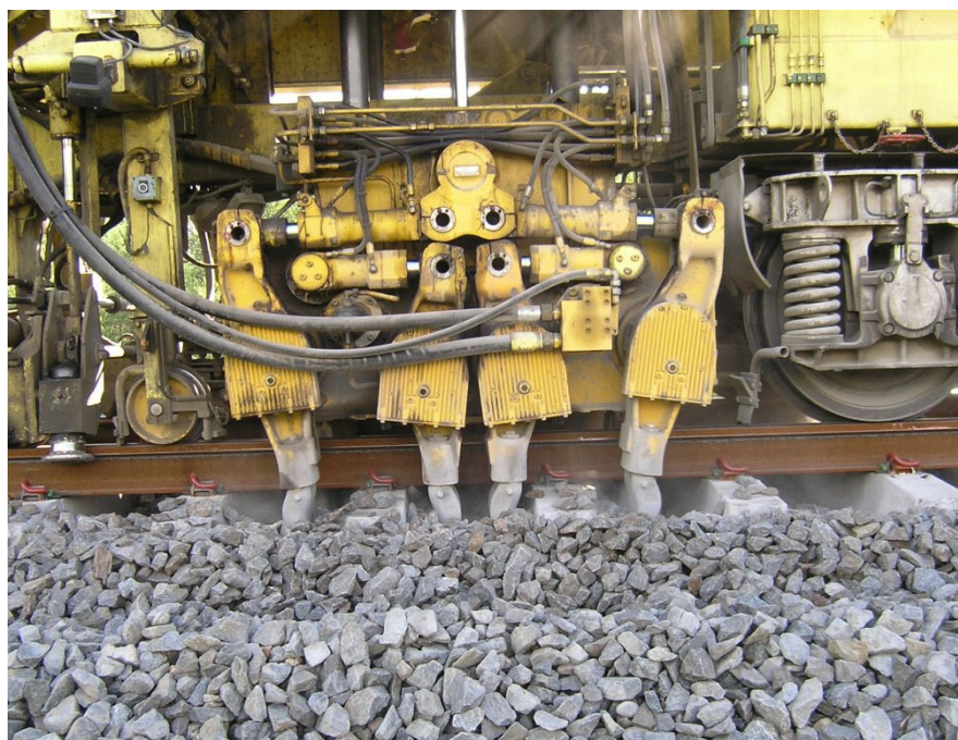
Figur 3.10 Korrigering av järnvägsspåret (foto: David Lehtonen)
