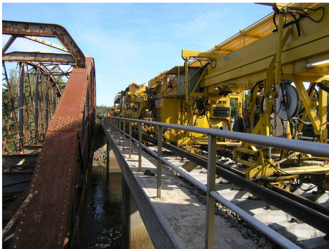
Figur 3.7 Stål och betongbro i Niemisel. På bilden syns även spårbytesmaskinen Matisa P95 (foto: David Lehtonen)
