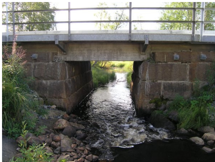
Figur 3.2 Betongbro längs järnvägen mellan Boden-Haparanda (foto: David Lehtonen)
