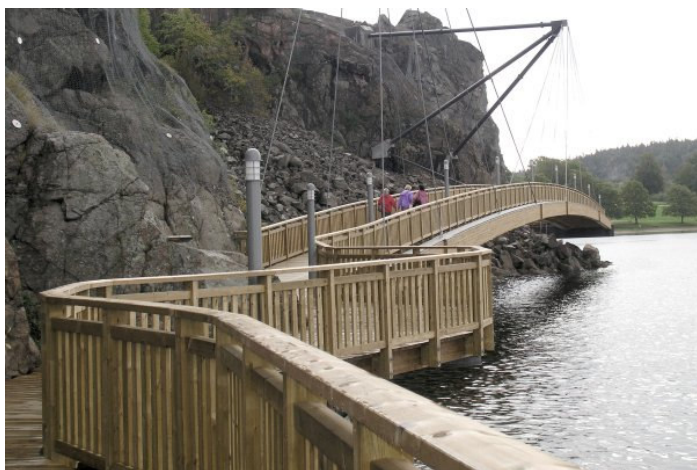
Figur 2.2 Hästepallarna, balkbro längs strandpromenaden i Uddevalla (foto: Martinsons Träbroar AB)
