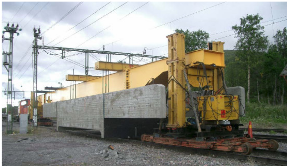
Figur 3.6 Brobyte med brobytesvagn, bilden visar transport till broläget, Banverket (2007a).
