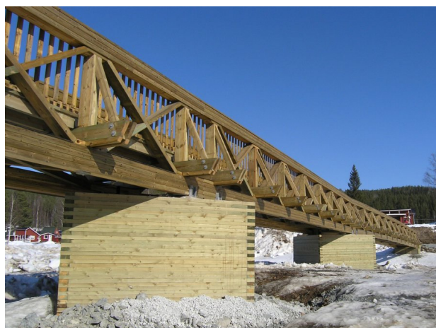
Figur 2.7 Fackverksbro vid Storforsen (foto: Martinsons Träbroar AB)
