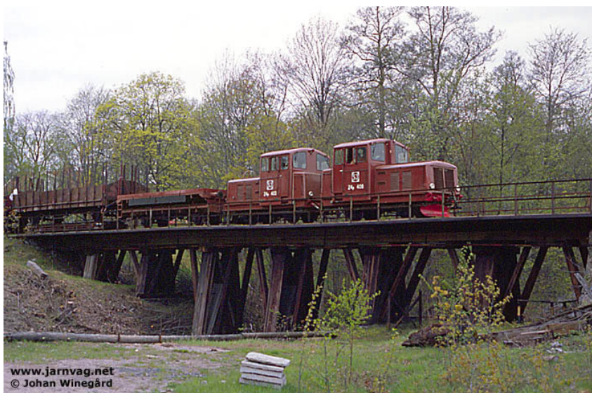
Figur 2.12 Järnvägsbro i trä på sträcka mellan Finspång oh Hjortkvarn, Järnväg.net (2007)
