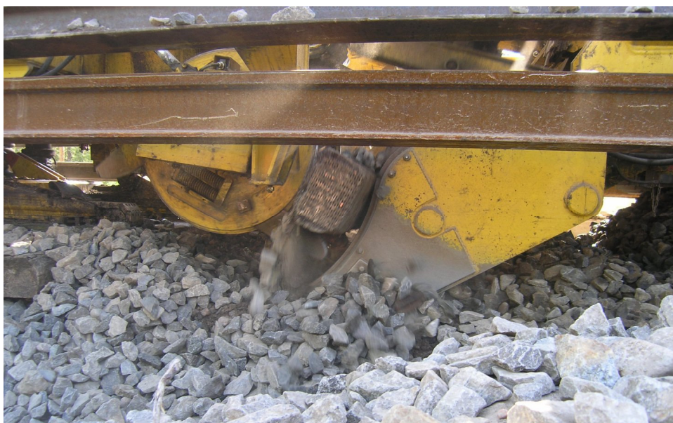
Figur 3.9 Gripklon som går under spårbytesmaskinen och lyfter ut gamla slipers ur spåret med hjälp av ett drivhjul (foto: David Lehtonen)
