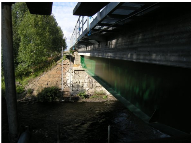
Figur 3.4 Samverkansbro längs järnvägen mellan Boden-Haparanda (foto: David Lehtonen)
