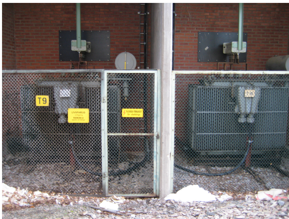
Figur 21. Transformator T9 och T10 sett utifrån.
