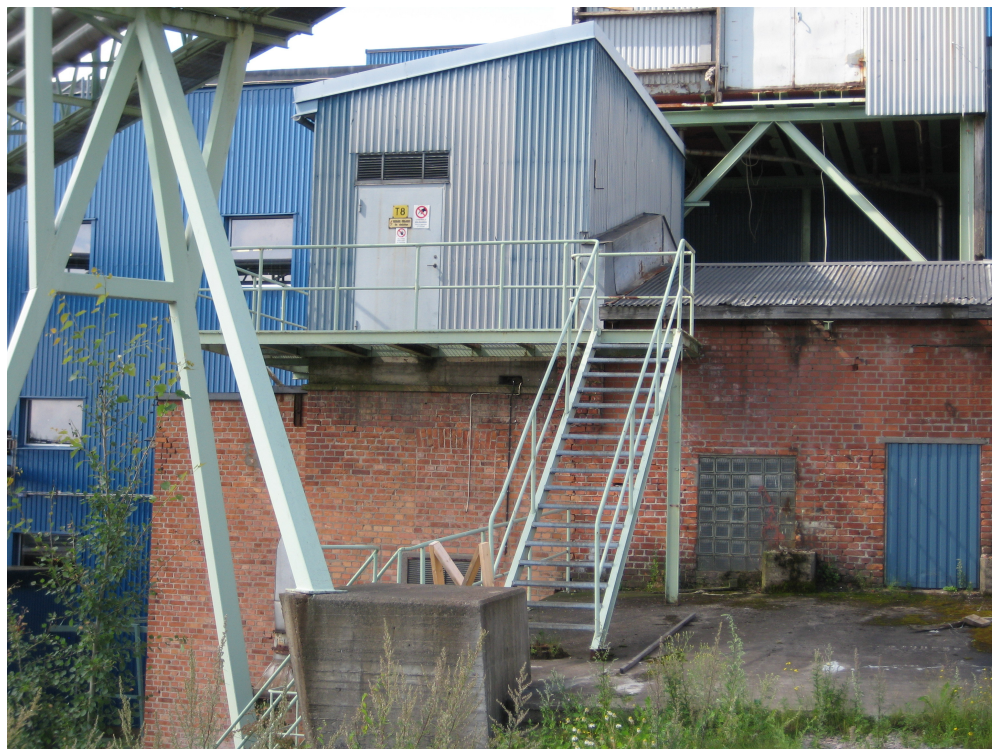
Figur 20. Lågspänningsställverk med transformator T8.
