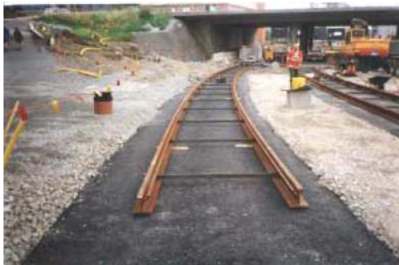
Figur 3.2b Asfaltspår under byggnation.
