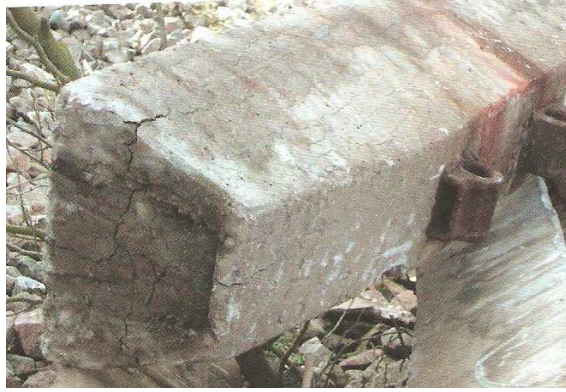
Figur 2.12 Slipersprickor
