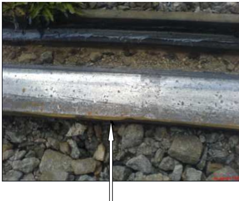
Figur 4.3 Sprickor i rälen
