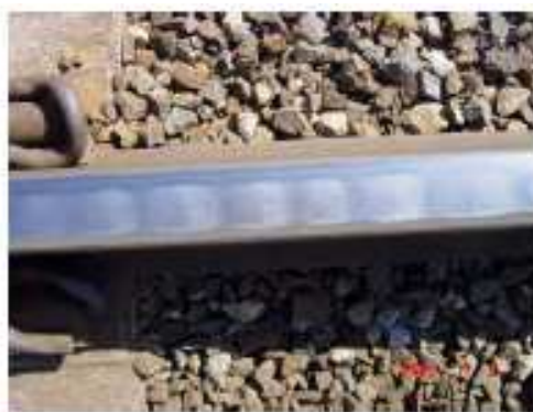
Figur 4.2 Räckflor i spåret (Foto: Infrateknik AB)
