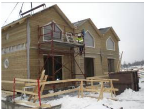
Bild 5.11 Färdigmonterad sjöbod vid monteringsplatsen i Sunnanå hamn
