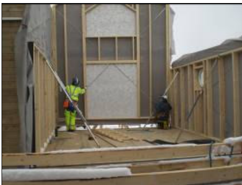
Bild 5.8 Gavelmontering vid Sunnanå hamn
