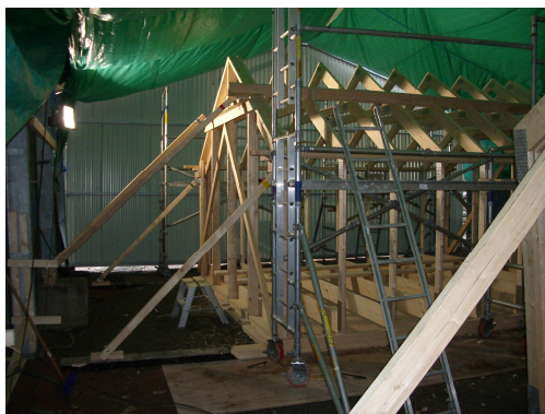
Bild 5.4 Förtillverkning av takdel vid tältet vid Sunnanå hamn
