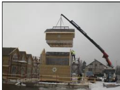
Bild 5.9 Takdel lyfts på plats vid monteringen vid Sunnanå hamn
