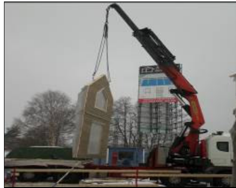
Bild 5.7 Lyftkran vid montering av sjöbod i Sunnanå hamn
