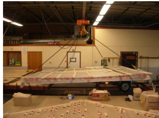
Bild 5.3 Lyft av byggnadsdel vid förtillverkningen i industrilokalen
