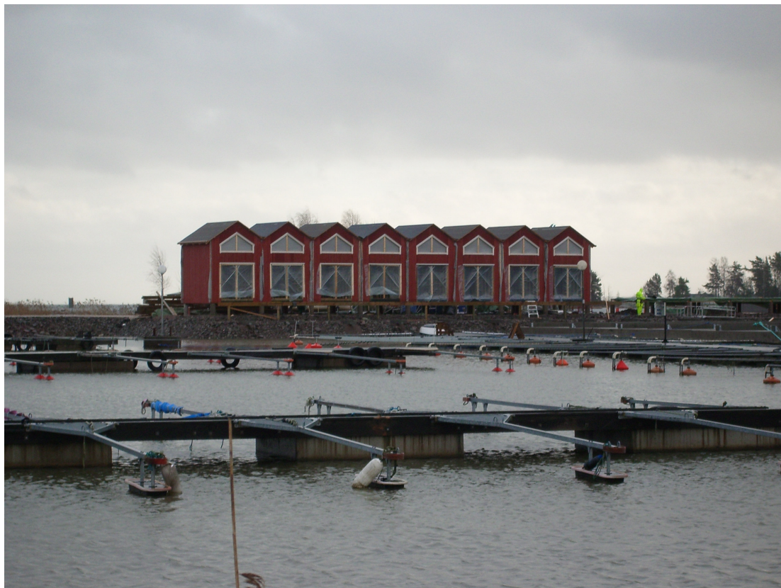
5 Bild 5.1 Sjöbodsbyggnation i Sunnanå hamn
