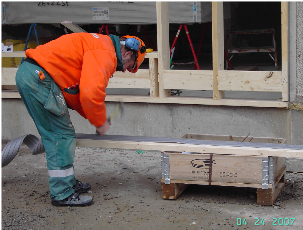
Figur 3.2 Fästning av sylltätning.
