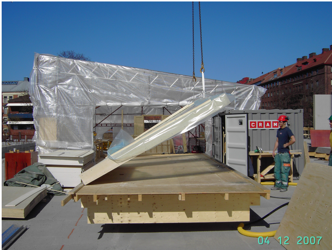
Figur 5.1 Kranlyft av vägg vid Venus fältfabrik.
