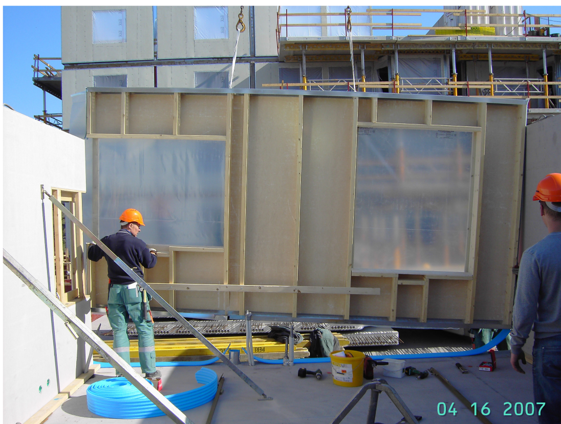
Figur 2.1 Placering av utfackningsvägg.
