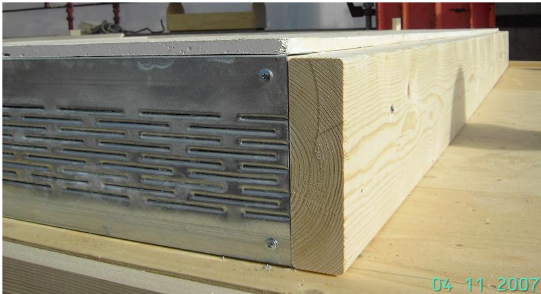
Figur 6.3 Vegg på monteringsbord med syll, stående regler och glasroc.
