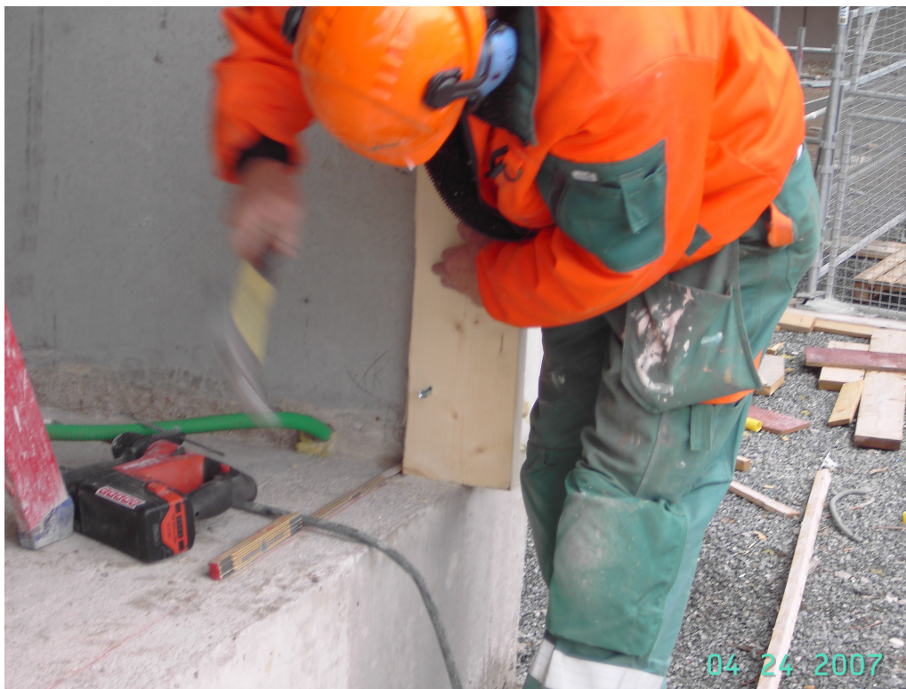
Figur 3.3 Infästning av regel i bärande betongstomme.
