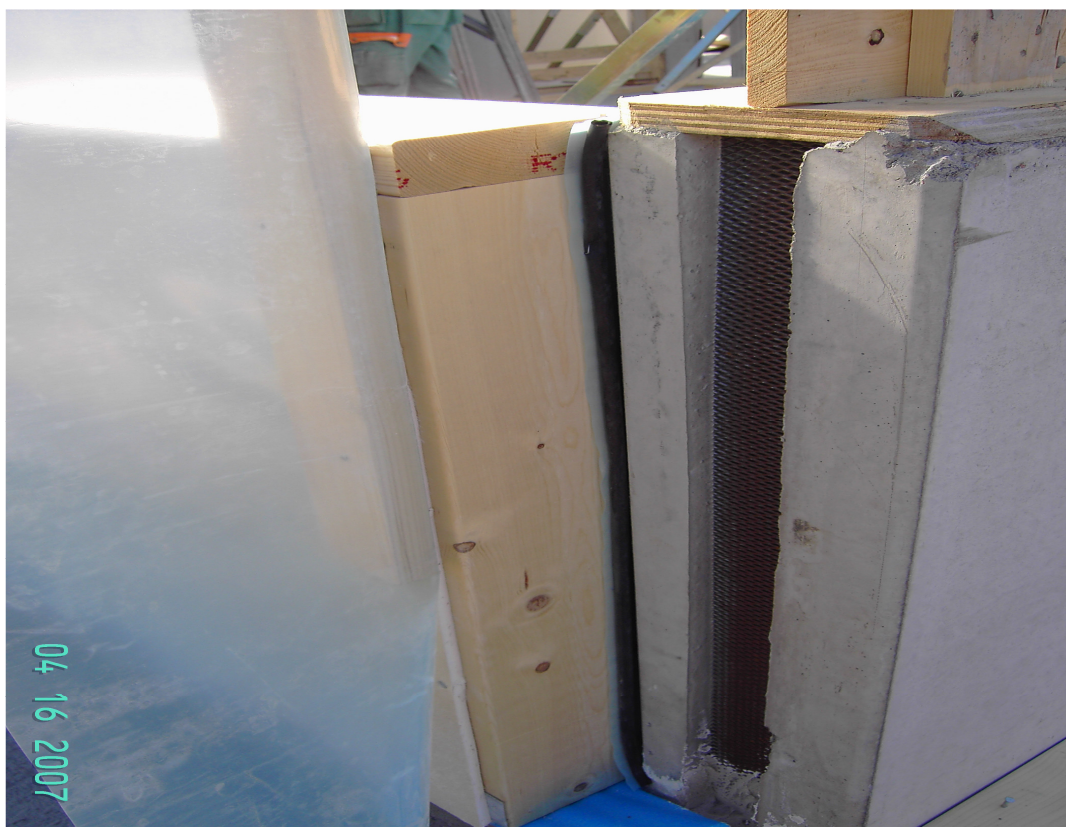
Figur 2.4 Placering av utfackningsvägg i förhållande till stommen.
