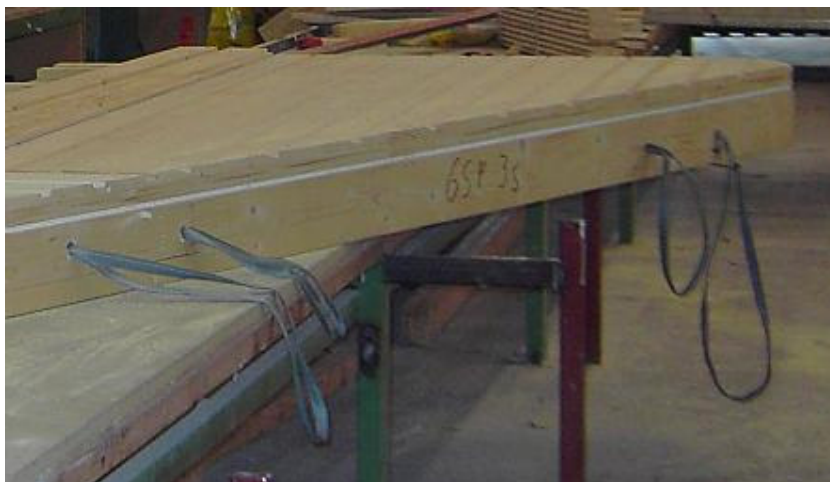
Figur 4.4 Stroppar för lyft av vägg.
