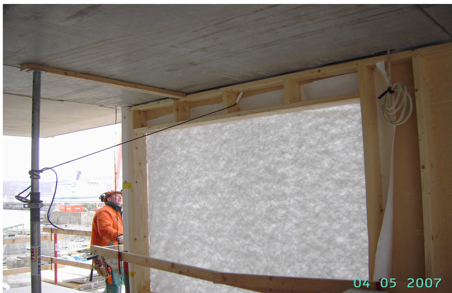
Figur 6.7 Utfackningsvägg tillverkat av träreglar och glasroc.
