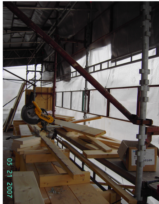
Figur 5.2b Kapsåg framför HAKI-ställning.
