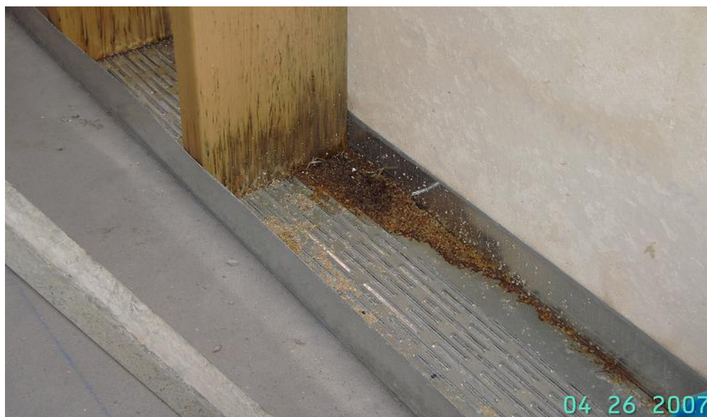
Figur 2.3 Här hade det varit bättre med stående plåtreklar.
