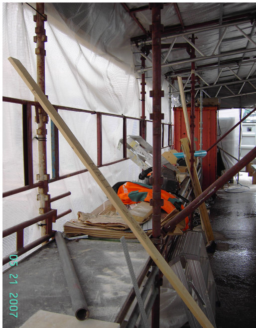
Figur 5.2a "Förvaring" av material på HAKI-ställning.
