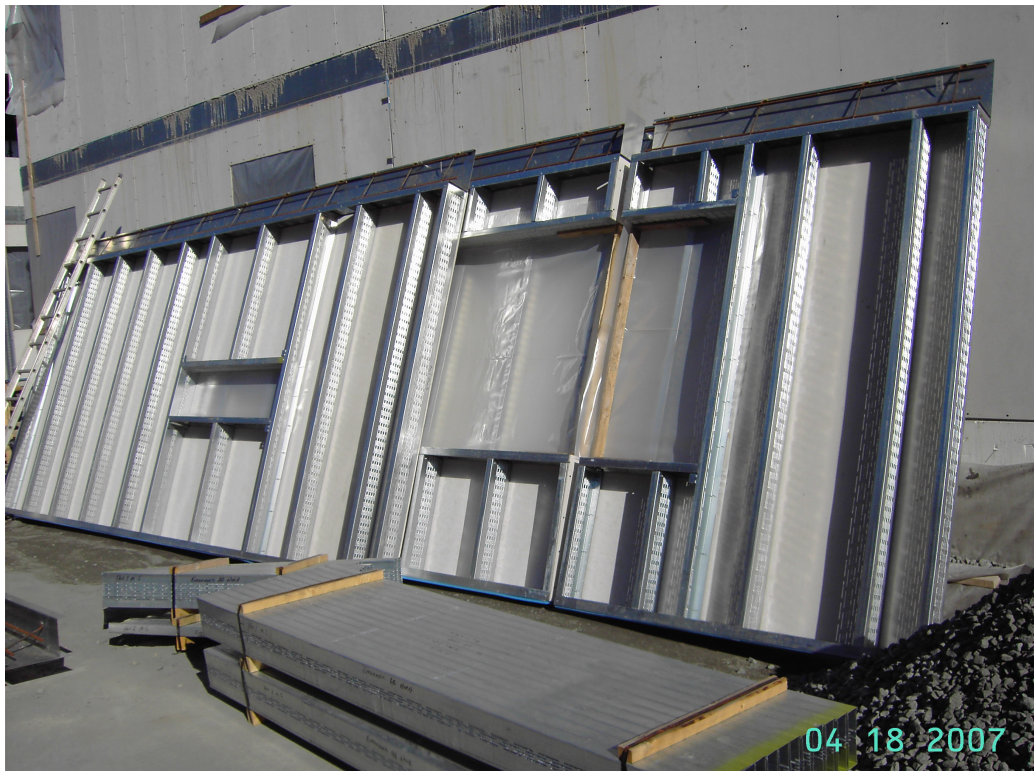
Figur 6.9 Utfackningsvägg av plåtreglar.
