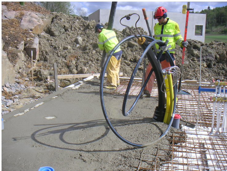
Figur 4.1 Gjutning av platta på mark i Östra Eklanda.
