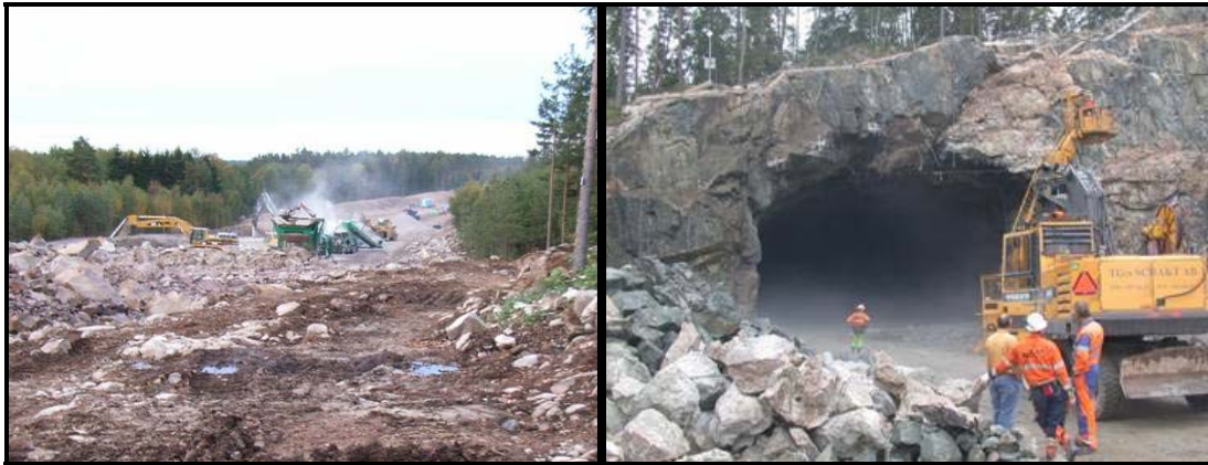
Bildserie 2: Anläggningsarbete på Norrortsleden.
