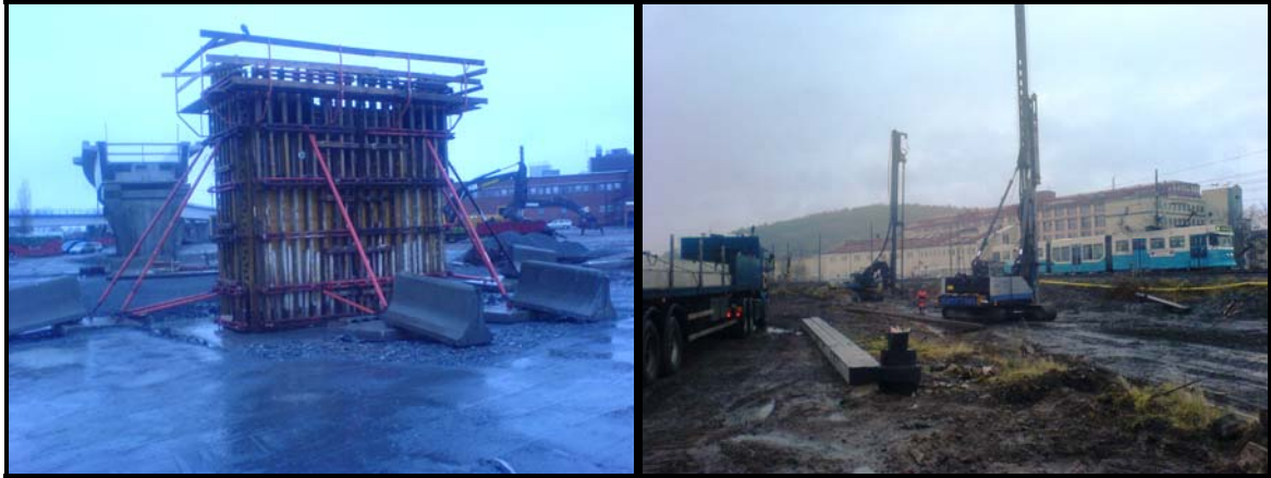
Bildserie 3: Betonggjutning och pålningsarbete på Marieholmsviaduktprojektet, hösten 2006.
