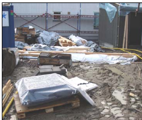
Bild 5.9 & 5.10 Material ligger utspritt på arbetsplatsen och på flera ställen direkt i leran. Materialet är genomblött och saknar täckning. Bilderna är tagna en fredag eftermiddag efter att byggnadsarbetarna gått hem för helgen.
