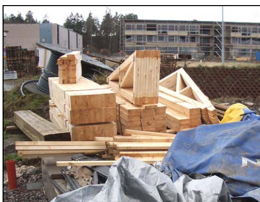
Bild 5.9 & 5.10 Material ligger utspritt på arbetsplatsen och på flera ställen direkt i leran. Materialet är genomblött och saknar täckning. Bilderna är tagna en fredag eftermiddag efter att byggnadsarbetarna gått hem för helgen.
