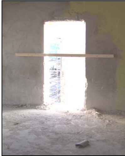
Bild 5.1 & 5.2 Bilden till vänster visar en öppning i ytterväggen på 4: e våning som saknar avspärningar i tillräcklig omfattning. Den högra bilden visar ett räcke som tagits ned och ej återmonterats fullt ut efter att material lastats upp den vägen.
