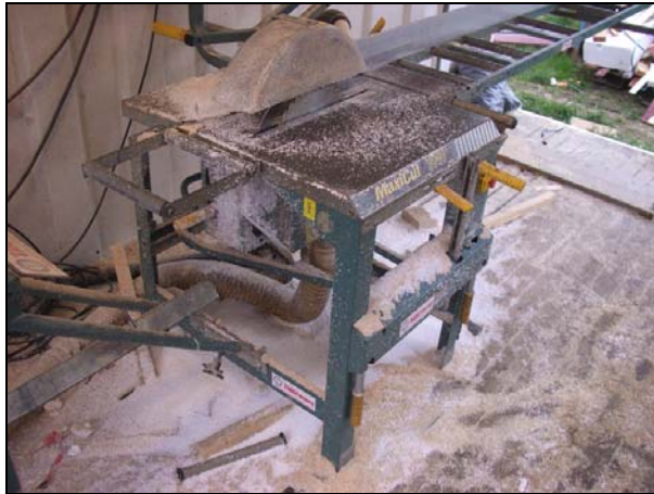
Bild 5.6 En byggsåg användes till att såga både trä och frigolit. Spånsugen som var kopplad till sågen fungerade inte då den var igensatt.
