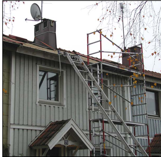
Bild 5.4 & 5.5 På bilden till vänster är avståndet mellan ställning och fasad för stort. På den högra bilden saknas ställning vid omläggning av tak.
