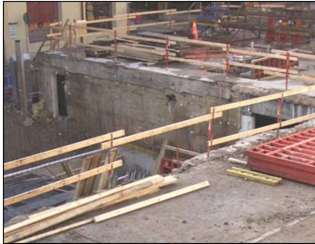
Bild 5.1 & 5.2 Bilden till vänster visar en öppning i ytterväggen på 4: e våning som saknar avspärningar i tillräcklig omfattning. Den högra bilden visar ett räcke som tagits ned och ej återmonterats fullt ut efter att material lastats upp den vägen.
