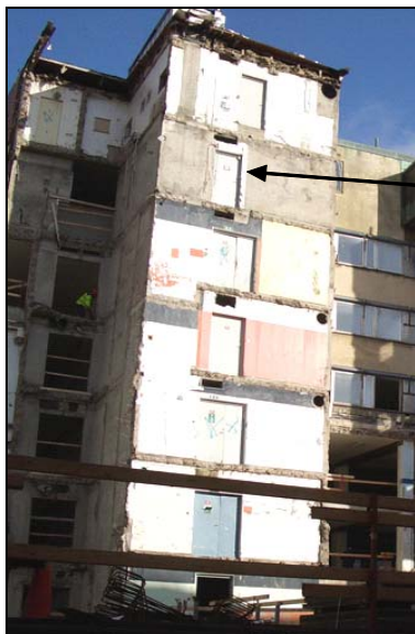
Bild 5.3 Vi ett ombyggnadsarbete ledde dörrar från ett bevarat trapphus ut i tomta intet. De flesta var låsta eller igensvetsade men en dörr var öppen med en kabel knuten kring trappräcket som enda säkring.
