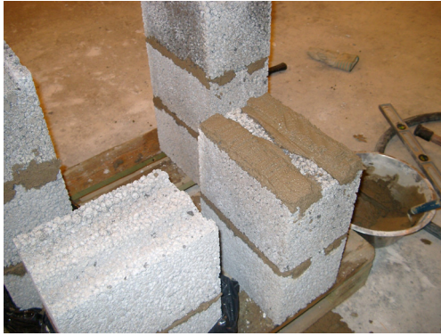
Figur 3.27. Tre block i höjd muras upp, här med B-bruk. Utsparningarna på blocken är riktade uppåt (Ludvigsson, 2004).
