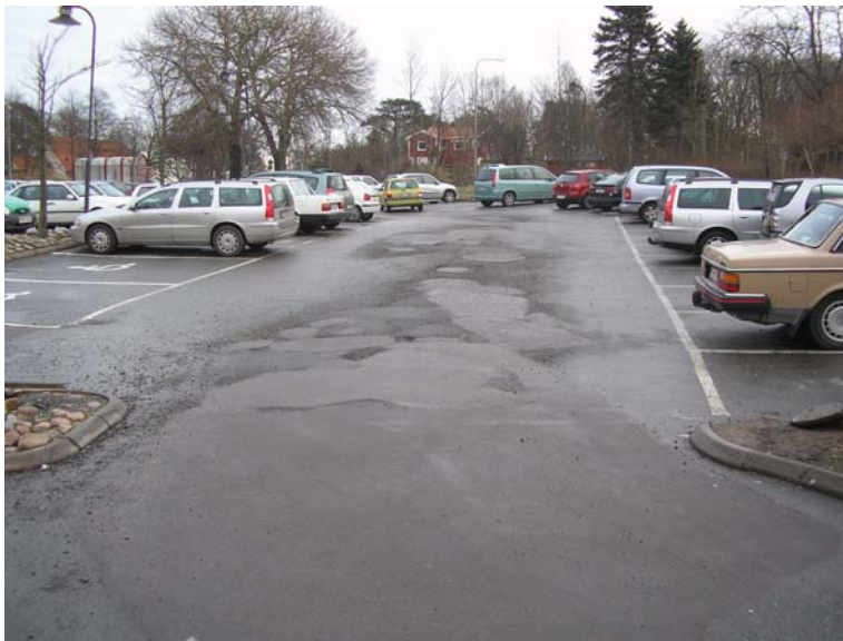
Bild 1. Skador i beläggningen på parkeringen vid Torslanda torg (Foto, Magnus Eldh)
