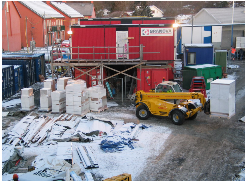
Bild 2.1.2. Teleskoptrucken transporterade antingen pallarna fram till rotortrucken eller till ett avlastningsområde som syns till vänster på bilden.
