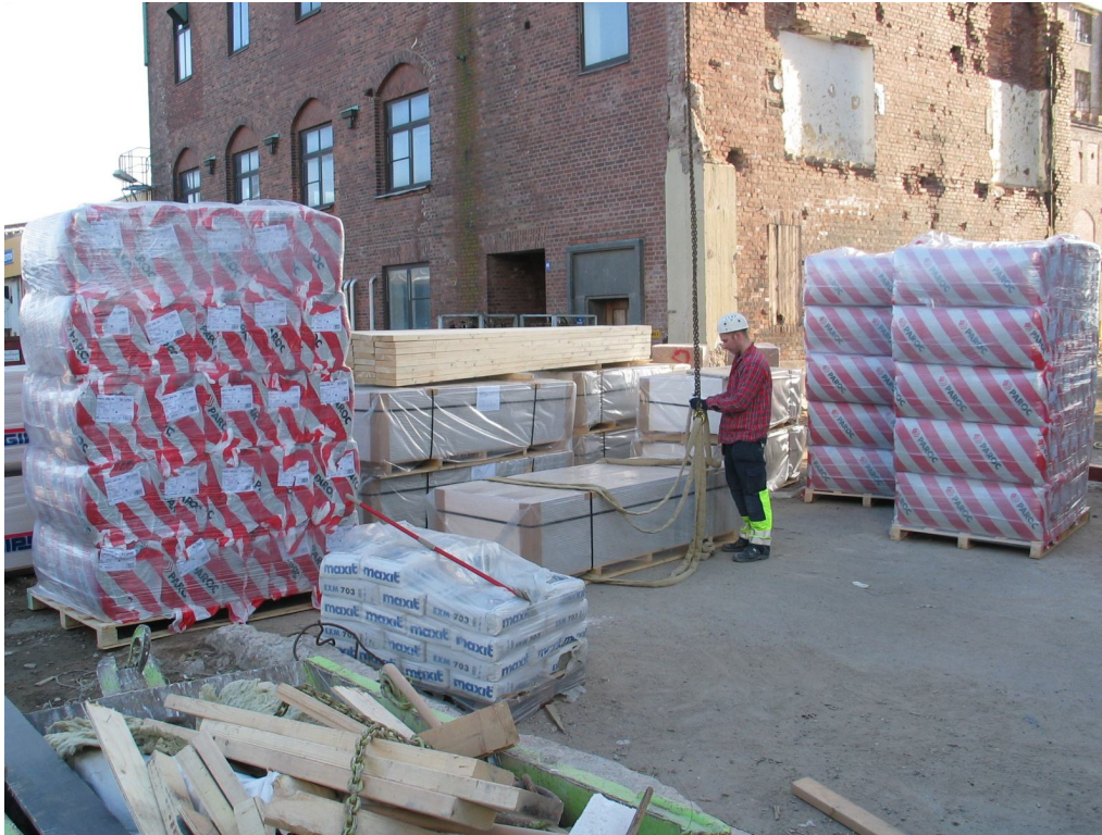
Bild 2.6.3. Transportör från Bygginlyft AB fäster pallarna vid kranen inför upplyftet.
