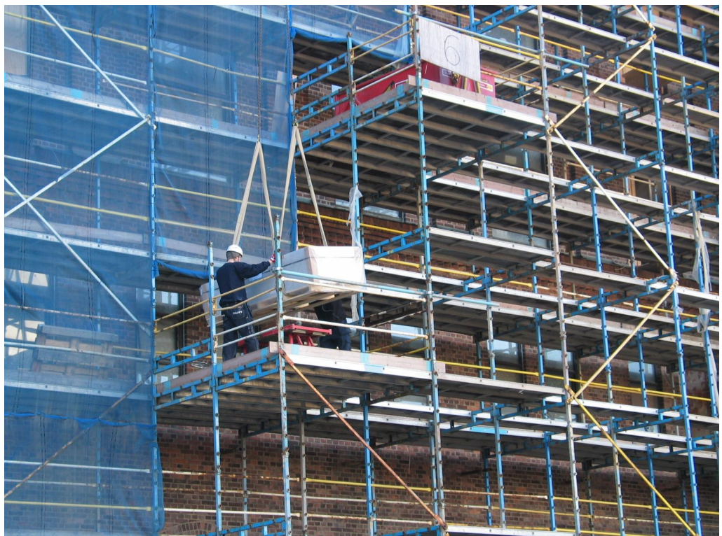
Bild 2.6.4. Pallarna lyftes med kranen upp till aktuell våning och tas emot av resterande transportörer.
