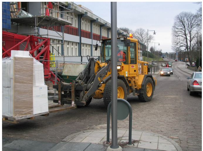
Bild 2.3.5. Vid eftermiddagsleveransen bar hjullastaren pallarna direkt över vägen istället för att först lasta av dem på andra sidan.
