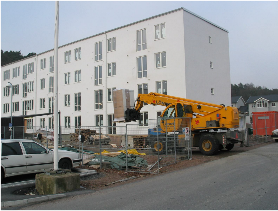
Bild 2.5.1. Rotortruck transporterar pallarna från avlastningsområdet fram till huset.
