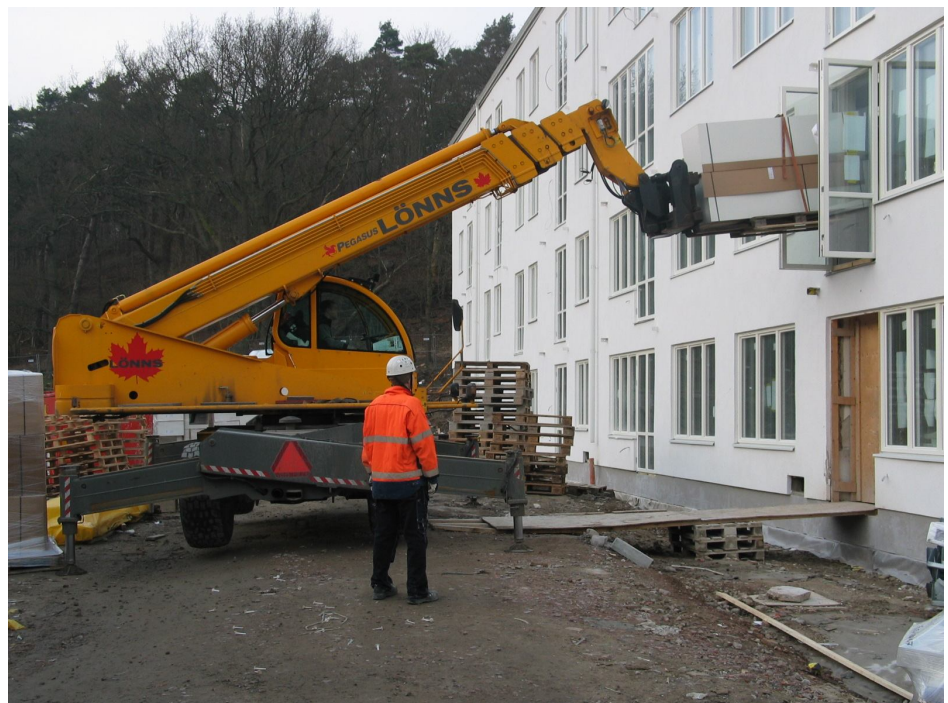
Bild 2.5.2. Rotortruckan lyfter in pallarna genom balkongfönstret där de omhändertas av transportörer.
