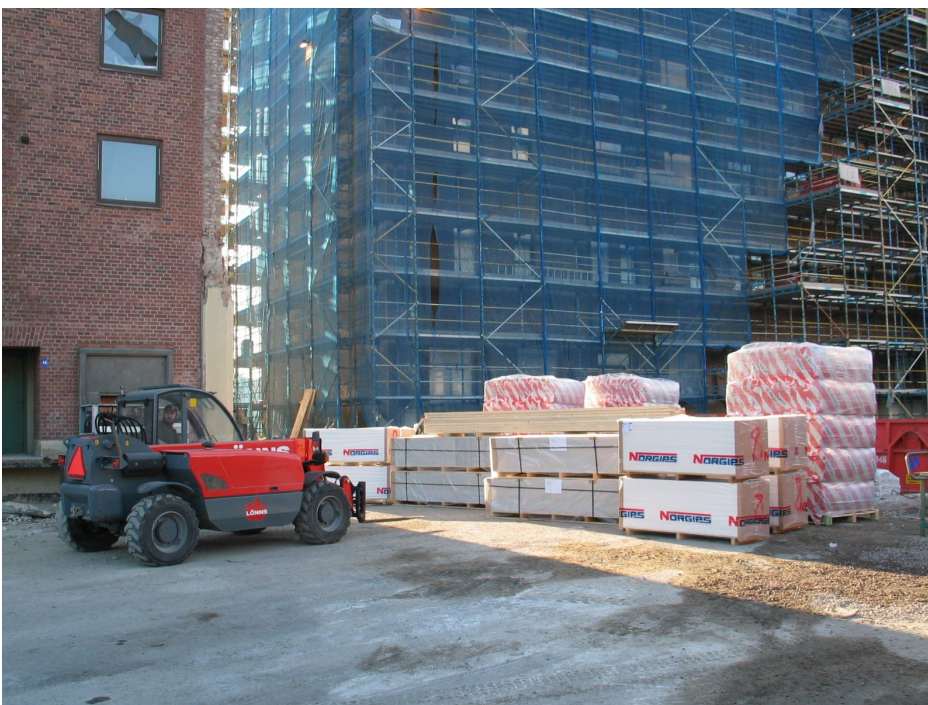
Bild 2.6.2. Lulltrucken transporterar pallarna med material till ett avlastningsområde inom räckhåll för kranen.
