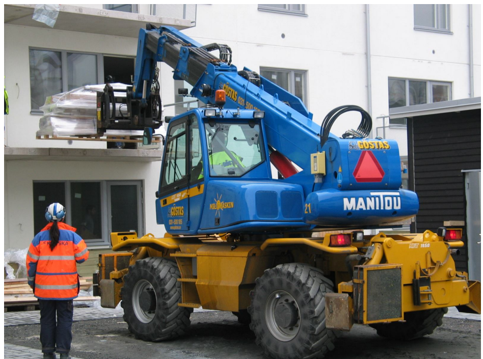
Bild 2.4.2. Rotortruckan lyfter pallarna upp till balkongen där de tas emot av montörer.
