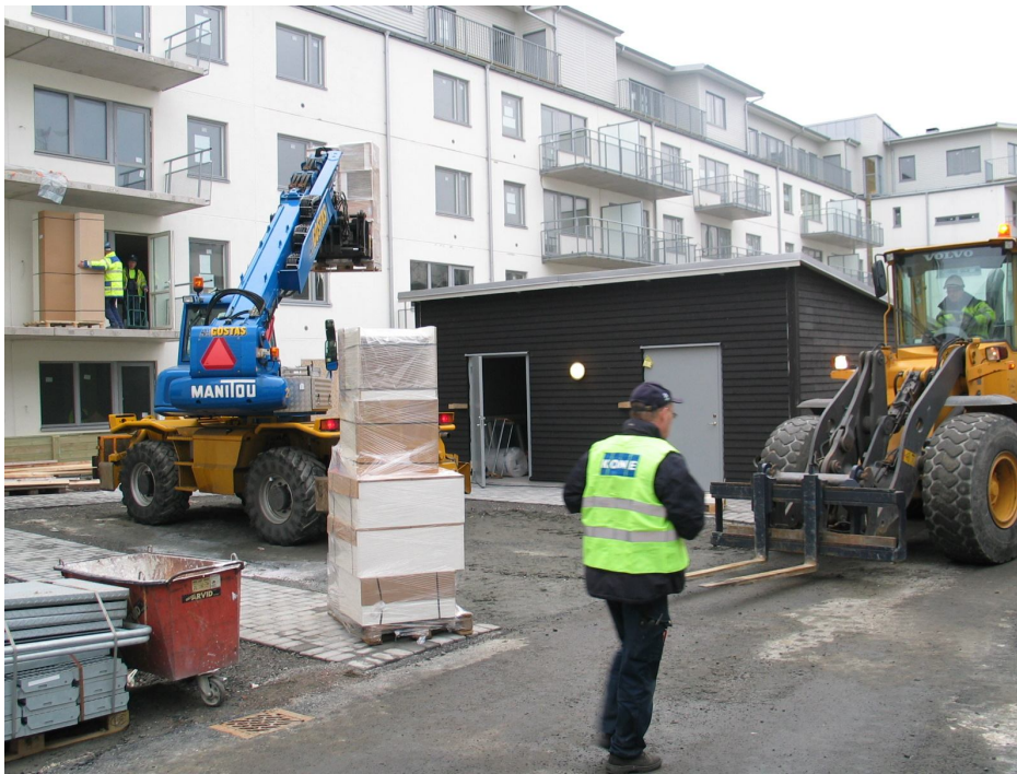
Bild 2.4.1. Hjullastaren transporterar pallarna inom räckhåll för rotortruckan. Lamellhuset syns till vänster i bilden.
