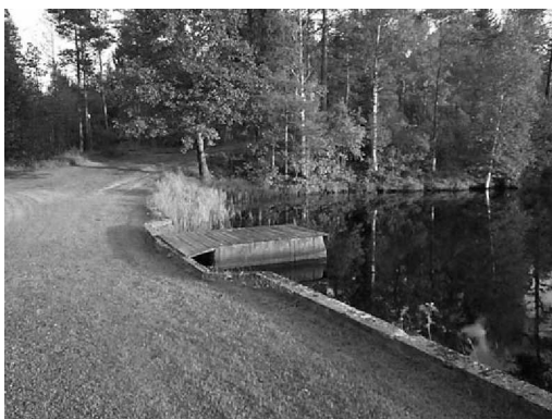
Bild 6. Vy över betong/ ekdamm. (Engström, L)
