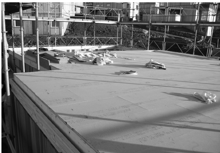
Figur 17 Bjälklag och väggelement till undervåningen färdigmonterade
