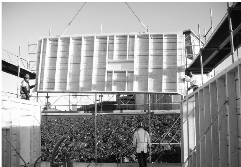
Figur 11 Inlyftning och inpassning av väggelement mellan redan monterade
