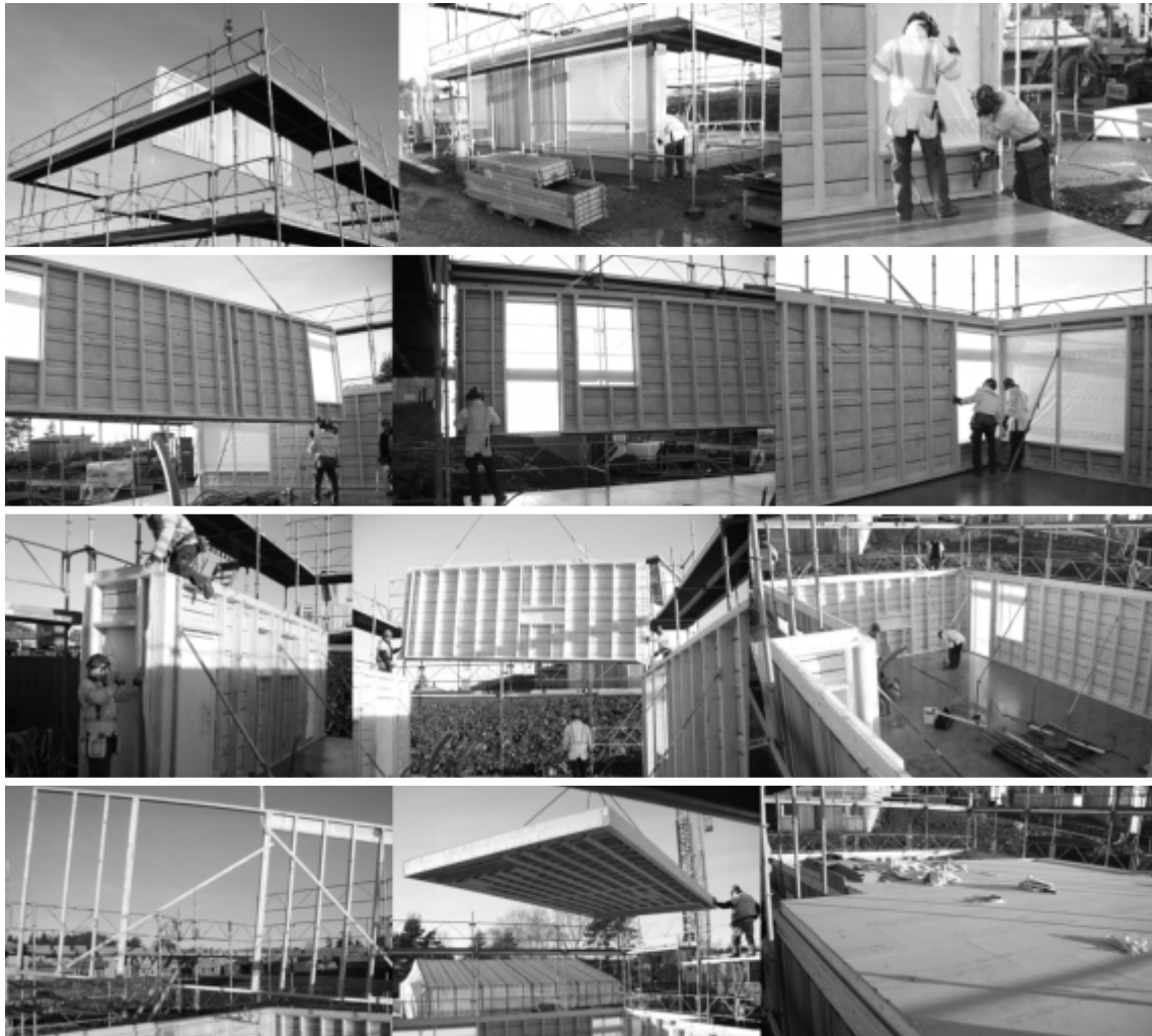
Figur 8.3 Samlingsbild: Montering av en undervåning till ett av husen tillhörande Projekt D, monteringen skedde på likartat tillvägagångssätt vid de övriga tre projekten.
