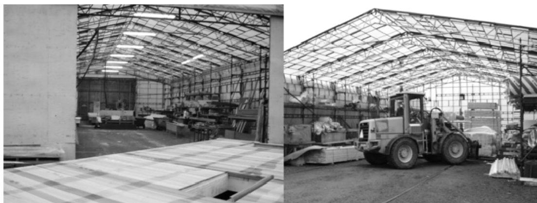
Figur 4.9-4.10, Produktion i Fältfabrik 2, vänstra bilden (4.9) visar när ett väggelement rullas ut från väggproduktionstältet för infästning av fönster och placering i väggställ. Bilden till höger (4.10) visar lagringsutrymme för virke och isolering.
