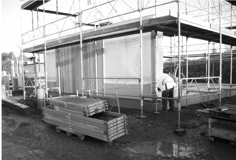
Figur 3 Inpassning av väggelementet
