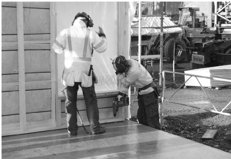
Figur 4 Infästning av väggelement i betongplattan
