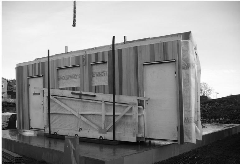
Figur 1 Väggelement i väggstöd inför montering
