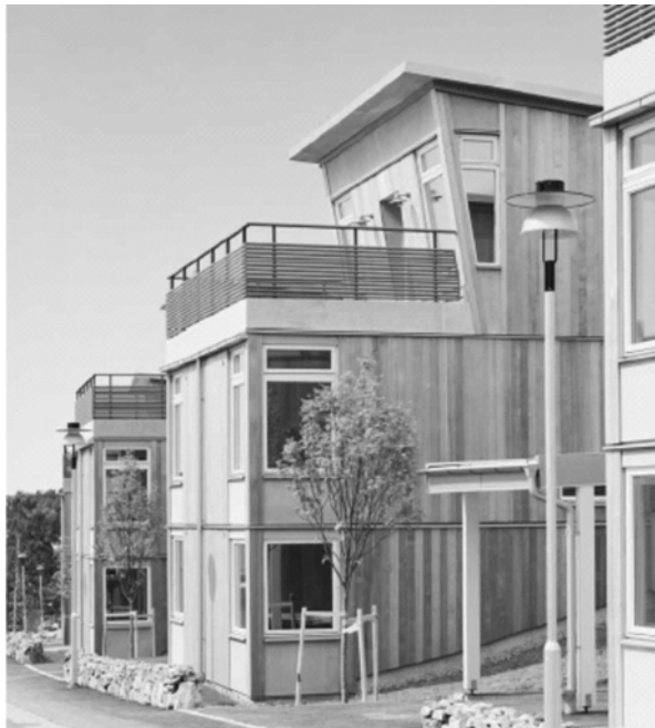
Figur 8.1 En av de fyra uppförda hustyperna inom projektet
