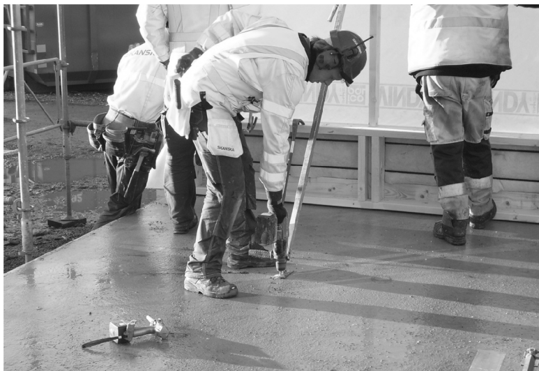
Figur 5 Montering av monteringsstöd till väggelement
