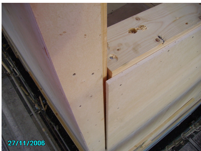
Figur 6.2 Dålig passform i ytterväggshörn p.g.a. skeva väggelement.
