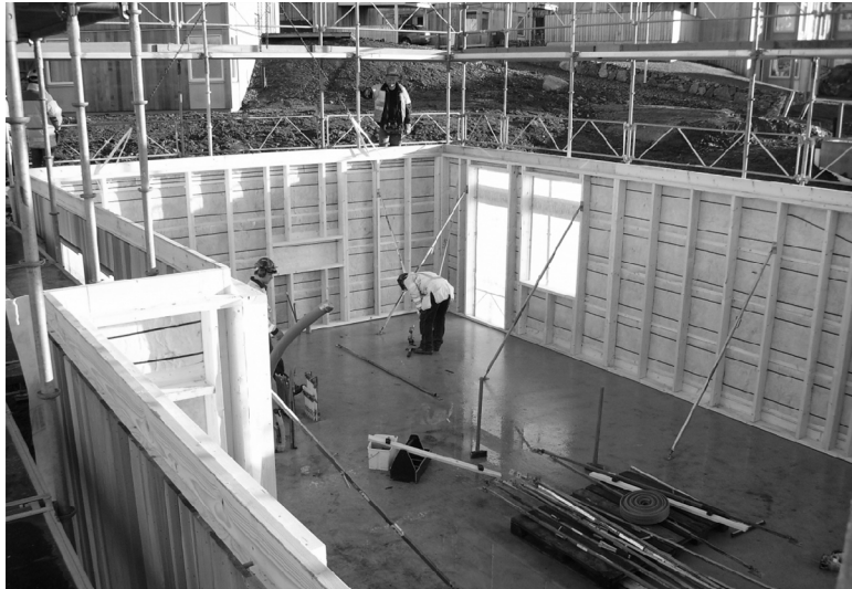
Figur 12 Undervåningens ytterväggar färdigmonterade
