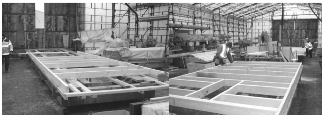
Figur 4.7-4.8, Produktion i Fältfabrik 2, bilden till vänster (4.7) visar uppregling av ett väggelement. Högra bilden (4.8) visar infästning av regler i väggelementet.
