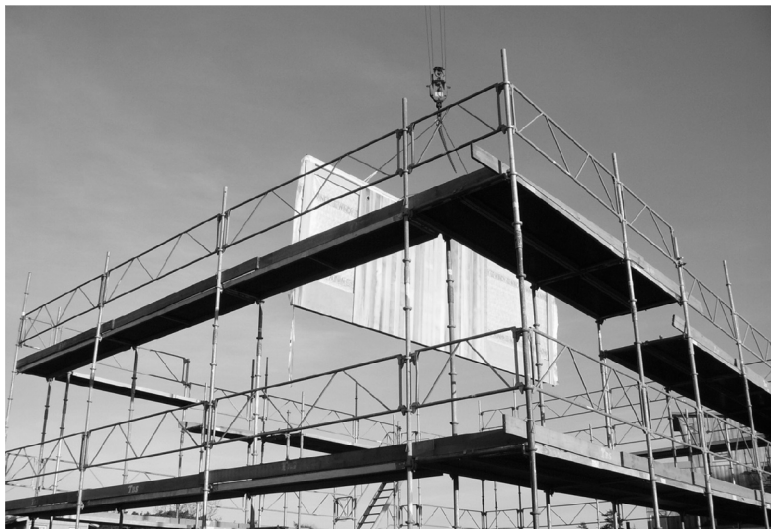
Figur 2 Inlyftning med kran av första väggelementet
