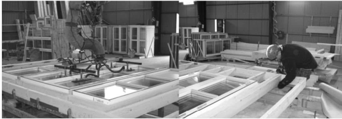
Figur 4.2-4.3 Produktion i Fältfabrik 1, vänstra bilden (4.2) visar insättning av fönsterenhet i väggelement med vakuumlyft. Bilden till höger (4.3) en yrkesarbetare som fäster fönsterenhet i väggelementet.
