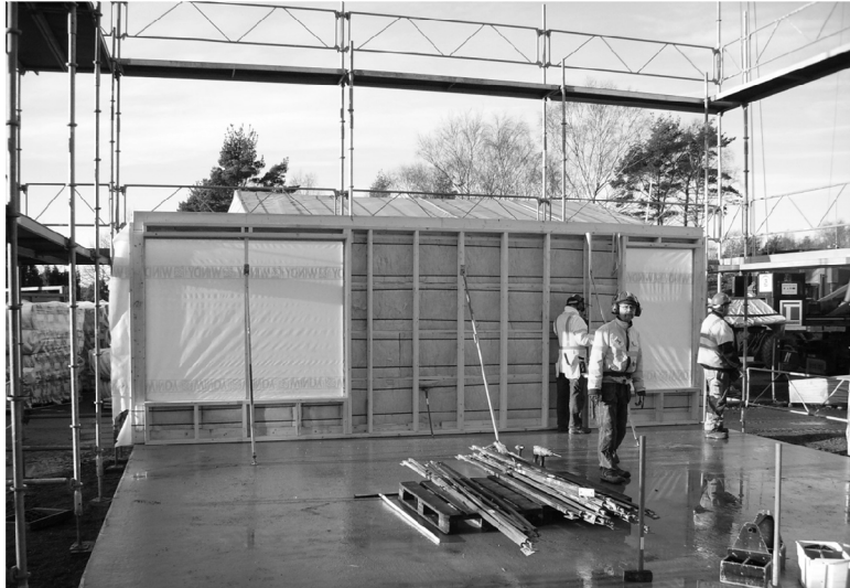
Figur 6 Första väggelementet monterat och strävat
