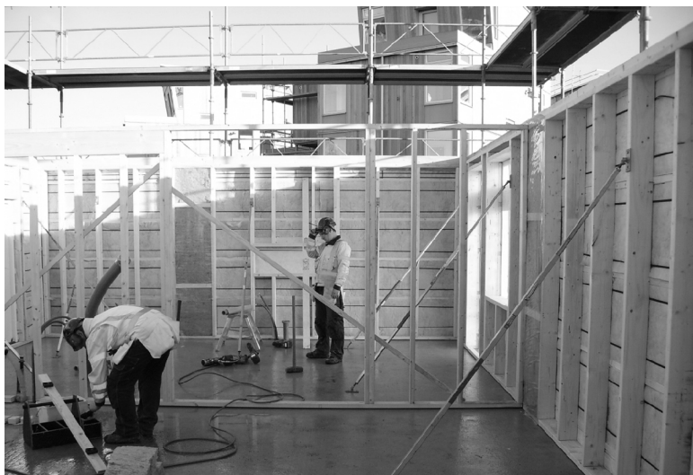
Figur 14 Montering av innervägg
