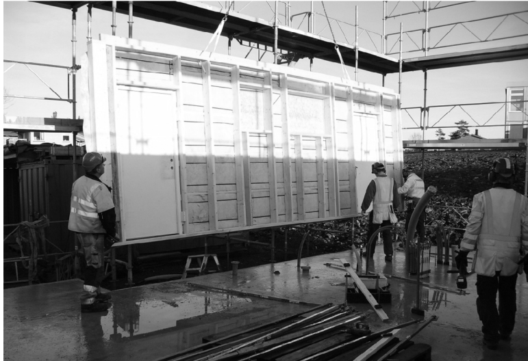
Figur 9 Inlyftning av ytterligare ett väggelement
