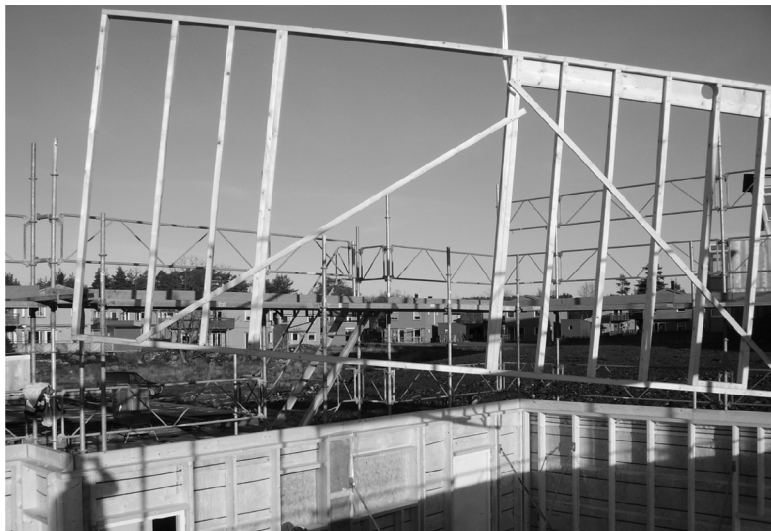
Figur 13 Inlyftning av innervägg
