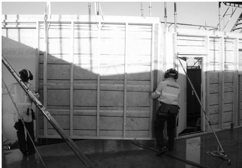
Figur 10 Inpassning av väggelement mot redan monterat
