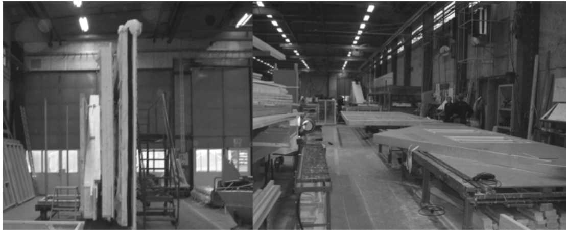
Figur 4.15-4.16 Produktion av väggelement vid Hustillverkare 1 i stationsbaserad miljö, ett huselement produceras komplett vid en station. Bilden till vänster (4.15) visar väggelement i väggställ innan täckning och transport till monteringsplats. Den högra bilden (4.16) visar den stationsbaserade produktionen, två stationer.
