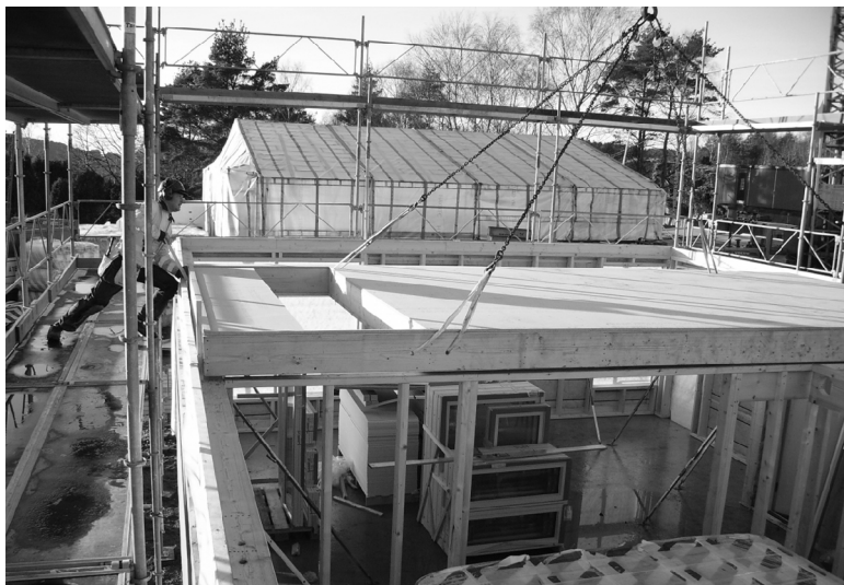
Figur 16 Inpassning av bjälklag
