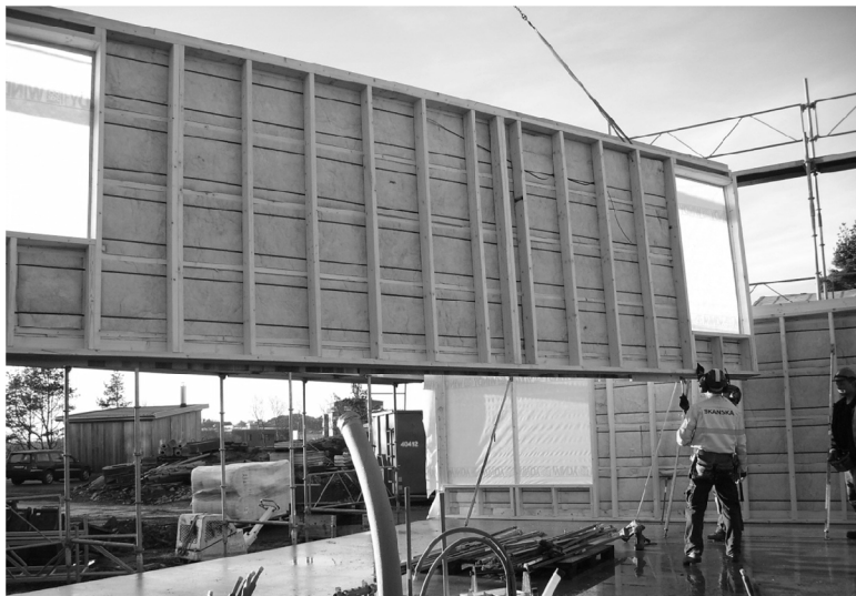
Figur 7 Inlyftning av andra väggelementet
