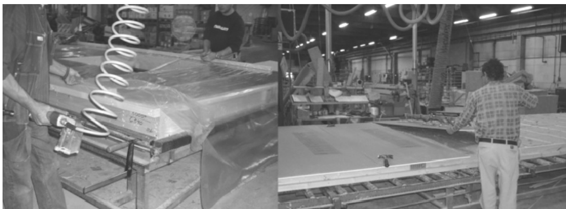
Figur 4.11-4.12 Produktion av väggelement med "linesystem" vid Hustillverkare 2. Bilden till höger (4.12) visar montering av gipsskivor på en innervägg med vakuumlift. Den vänstra bilden (4.11) visar infästning av "styrsvyll" på ett monterat ramverk.
