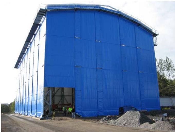
Figur 2.1 Monteringshall uppställd i Ursvik
