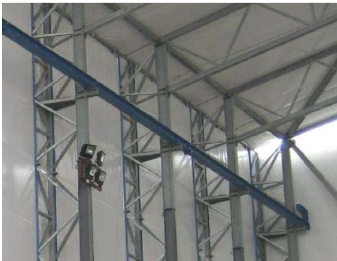
Traverssskena monterad på fackverkspelarna
