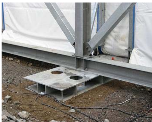
Stålfot med överliggande H-balk
