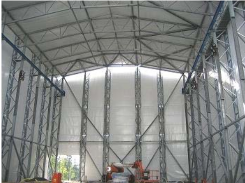
Hallkonstruktionen från insidan
