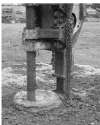
a) Tillverkning av MDM-pelare
