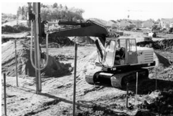
Figur 7.2 Nedslagning av RR-pålar ( www.hercules.se )
