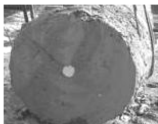
Figur 8.2 Figuren visar hur ett GEWI-stag är nedstucket i en uppdragen MDM-pelare (www.hercules.se)
