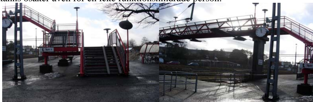
Figur 15 Gångbro vid Stenungsund station
