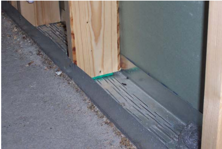
Figur 11. Under reglarna i utfackningsväggarna placeras distansbrickor för att förhindra fuktupptagning. Under stålsyllen syns den polyetenfilt som normalt utgör fuktskydd. Foto: Daniel Johansson, september, 2004.
