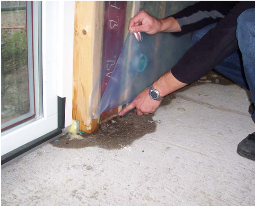
Figur 15. Regnvatten som kommer in främst vid balkongerna rinner in i väggen och ofta vidare ner till bjälklagen via ståpelarna. Här syns tydligt hur vatten har sugits upp i en träregel. Av bilden framgår att isolering och plastfolie är monterad. Foto: Daniel Johansson, september, 2004.
