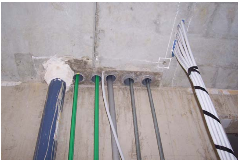
Figur 13. Stamledningar för vatten, avlopp, värme m m gjuts in i bjälklaget direkt i samband med pågjutningen av plattbärlagen, istället för att först dras i öppna schakt. Detta hindrar under produktionskedet vatten att sprida sig till underliggande våningar. Fördelar med att de dras vertikalt och rakt är att inspektion, felsökning och upptäckt av skada när huset är färdigställt underlättas. Foto: Daniel Johansson, september, 2004.
