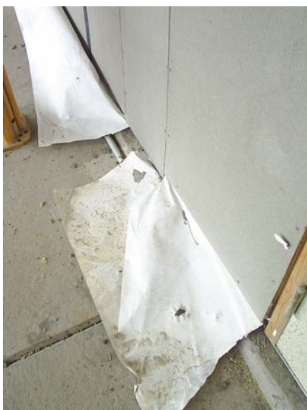
Figur 24. Vattenavvisande papp i nedre kanten på utfackningsväggar skyddar underliggande konstruktion. Foto: Marcus Stjernedal, september, 2004.
