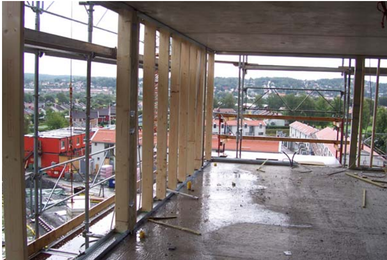
Figur 18. Trävirket i utfackningsväggarna utsätts för vädret så länge inte vindskyddsskivorna är monterade. Här syns hur regn har slagit in. Foto: Daniel Johansson, september, 2004.
