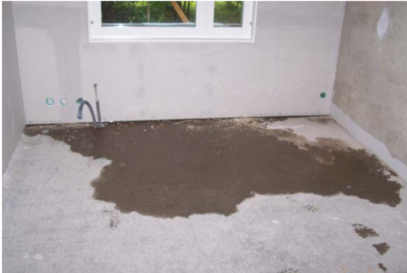
Figur 17. I den värst drabbade lägenheten har det bildats en vattensamling till följd av att regnvatten runnit in i väggen och ner på betongplattan. Denna lägenhet ligger i bottenvåningen. Som syns på bilden är invändiga gipsskivor monterade. Dessa skulle monteras ner och väggen saneras. Foto: Daniel Johansson, september, 2004.
