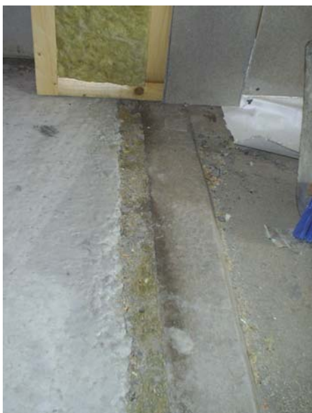
Figur 26. Oskyddad mineralull mellan bjälklag och balkong. Foto: Daniel Johansson, september, 2004.
