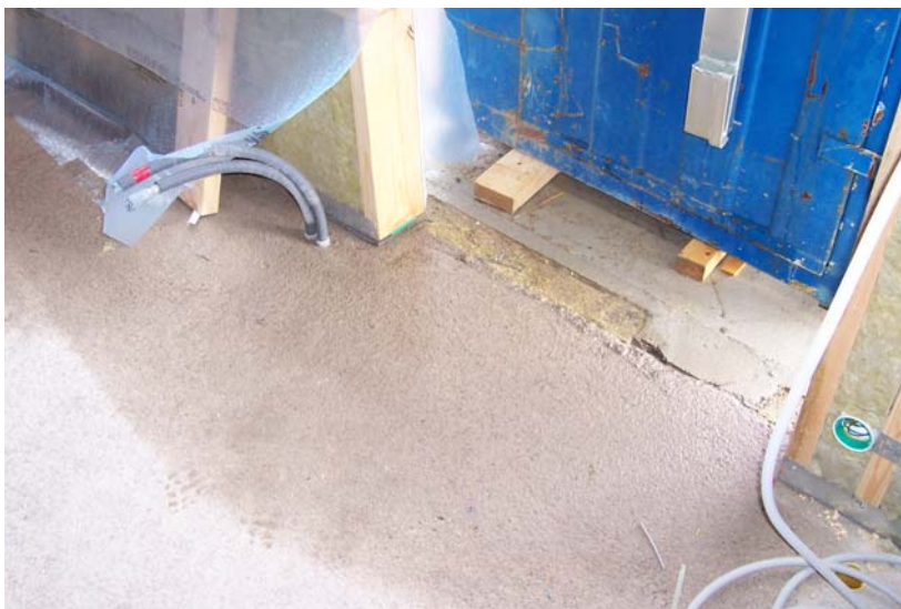
Figur 16. Balkonginfästningen sedd ovanifrån under produktionsskedet. Isoleringen mellan balkong och bjälklag är utan skydd och därmed utsatt för väderpåverkan. De mörka partierna på betongen visar på att det nyligen har regnat. Foto: Daniel Johansson, september, 2004.
