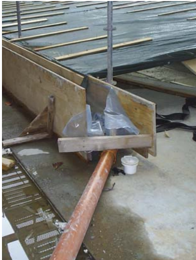
Figur 21. Tillfällig lösning för skydd mot nederbörd över en ljusbrunn. Regnvattnet leds till en golvbrunn. Foto: Marcus Stjernedal, september, 2004.
