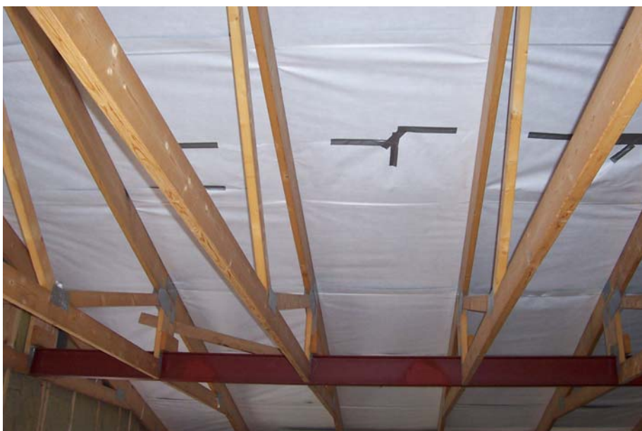
Figur 14. Underlagstaket av polyetenfibrer (den vita duken) skadas vid takläggningsarbetet. Skadorna lagas med tejp. Foto: Daniel Johansson, september, 2004.
