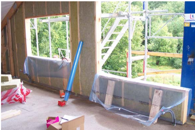
Figur 12. Byggnadsarbetarna tar egna initiativ och täcker oskyddat material. Foto: Daniel Johansson, september, 2004.
