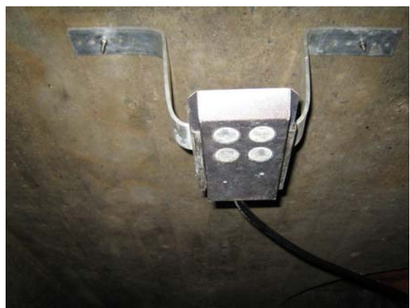
Figur 7: Ekolod för nivåmätning över skibord
