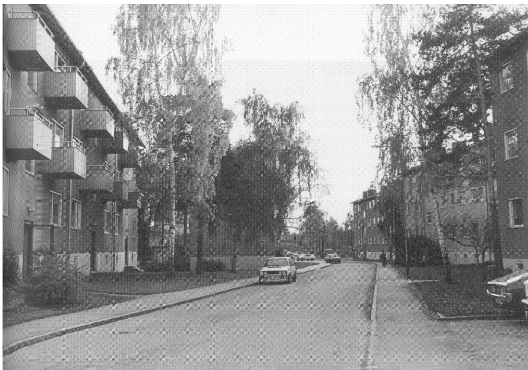
Figur 2.6 Ett av Svenska Riksbyggens större bostadsprojekt 1942. Hammarbyhöjden i Stockholm
