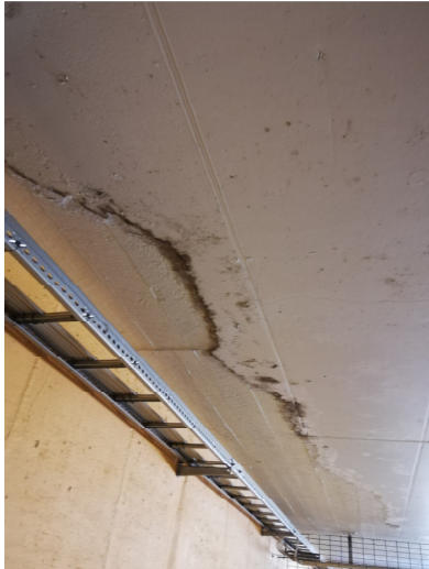
Figur 6.12. Cirka 9 st lagningar observerades där vidhäftningen börjat släppa. Författarens egna bilder.
