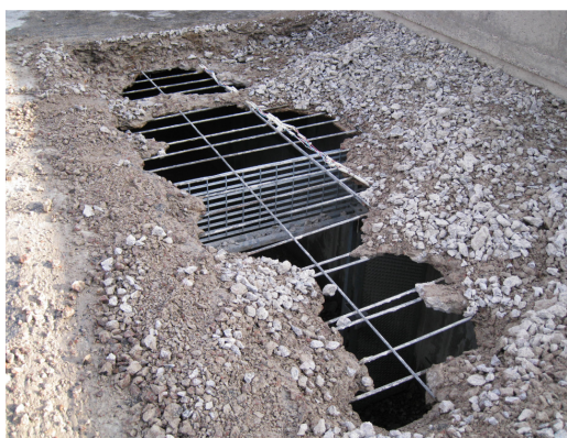
Figur 6.8. Exempel på hål igenom bjälklag efter bilning. Återgiven med tillstånd.
