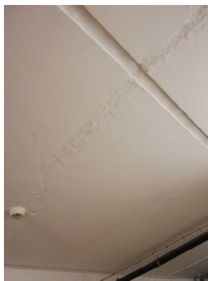
Figur 6.17. Exempel på lagning med estetisk defekt. Författarens egen bild.
