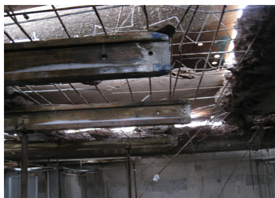
Figur 6.8. Exempel på hål igenom bjälklag efter bilning. Återgiven med tillstånd.
