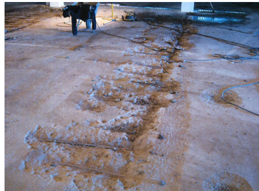
Figur 6.6. Bjälklag efter bilning. Återgiven med tillstånd.
