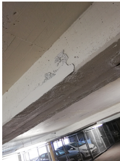
Figur 6.12. Cirka 9 st lagningar observerades där vidhäftningen börjat släppa. Författarens egna bilder.
