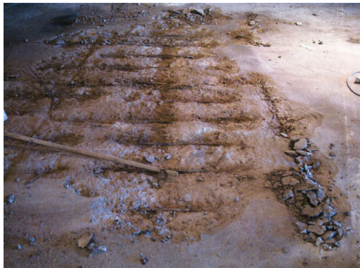
Figur 6.6. Bjälklag efter bilning. Återgiven med tillstånd.
