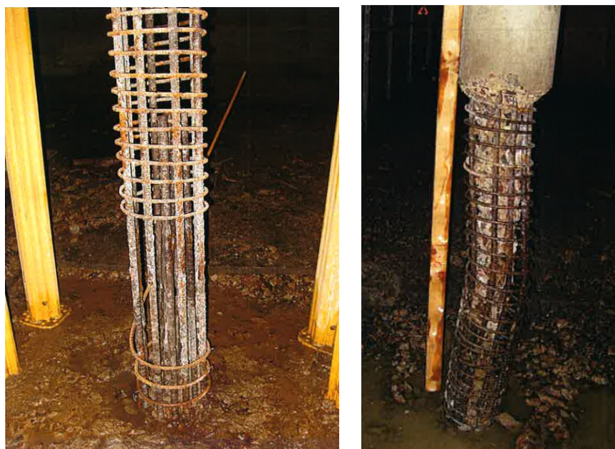
Figur 6.10. Pelare efter vattenbilning. Återgiven med tillstånd.
