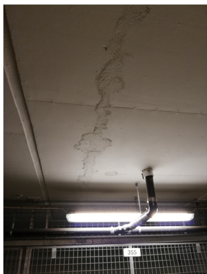
Figur 6.17. Exempel på lagning med estetisk defekt. Författarens egen bild.
