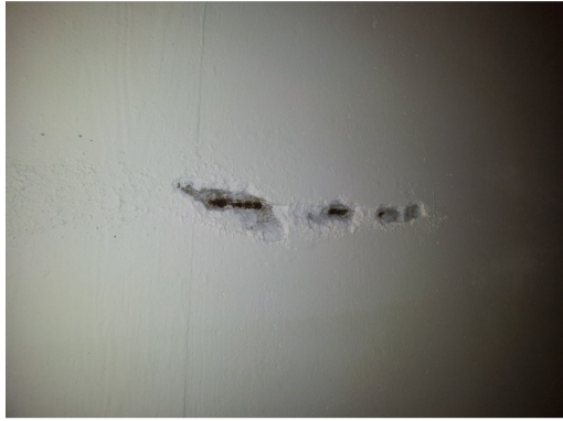
Figur 6.4. Synlig armering före reparations tillfälle samt skada där betong har spjälkat. Återgiven med tillstånd.
