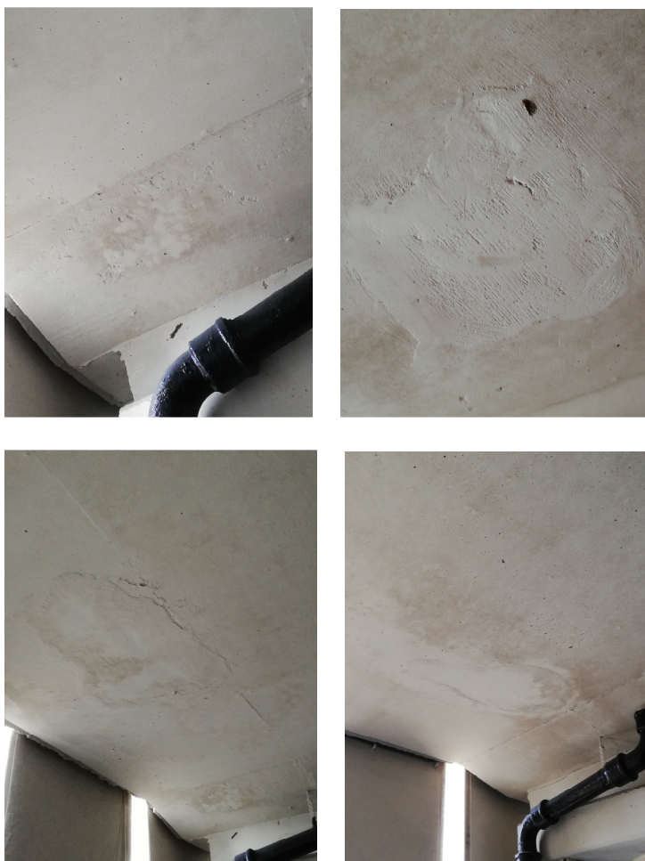
Figur 6.3. Exempel estetiska defekter. Författarens egna bilder.
