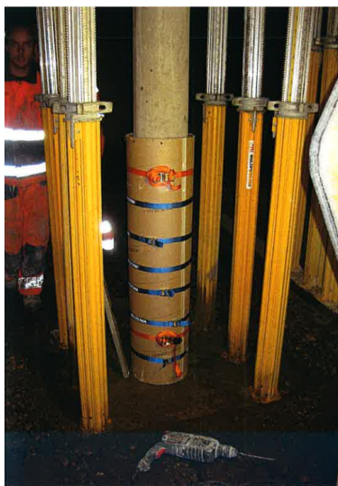
Figur. 6.11. Formar före gjutning. Återgiven med tillstånd.
