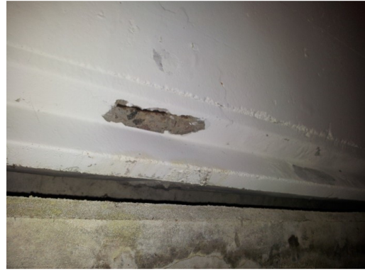
Figur 6.4. Synlig armering före reparations tillfälle samt skada där betong har spjälkat. Återgiven med tillstånd.
