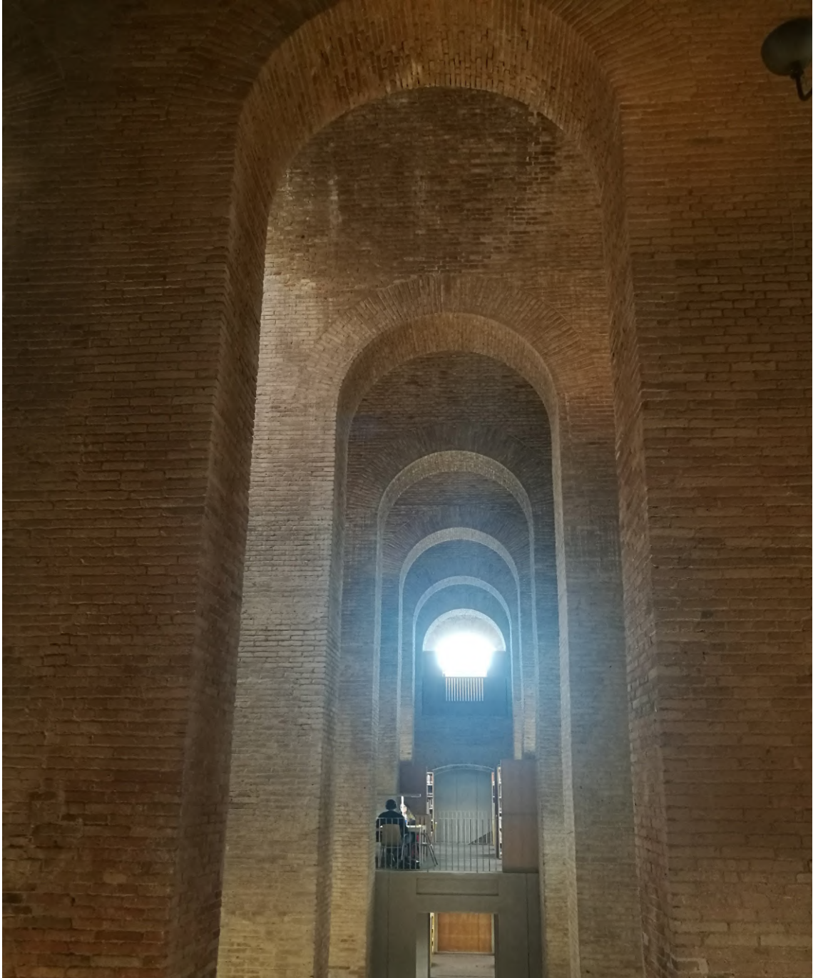
Reading balcony Biblioteca deposit de aigues
