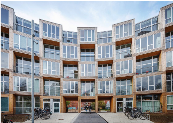
Fig. 51. Dortheavej, exterior (Hjortshøj, 2018a)
