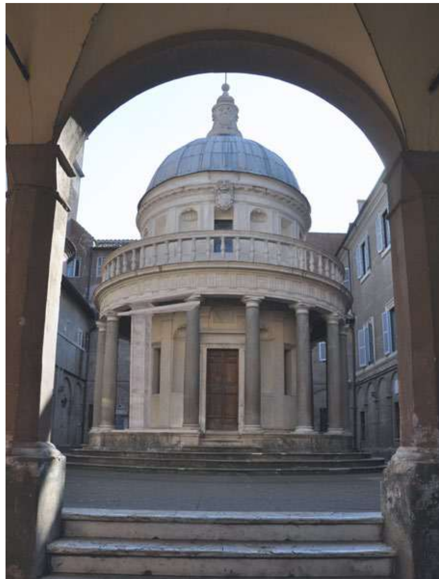
Tempietto Exterior with column nr. 7
