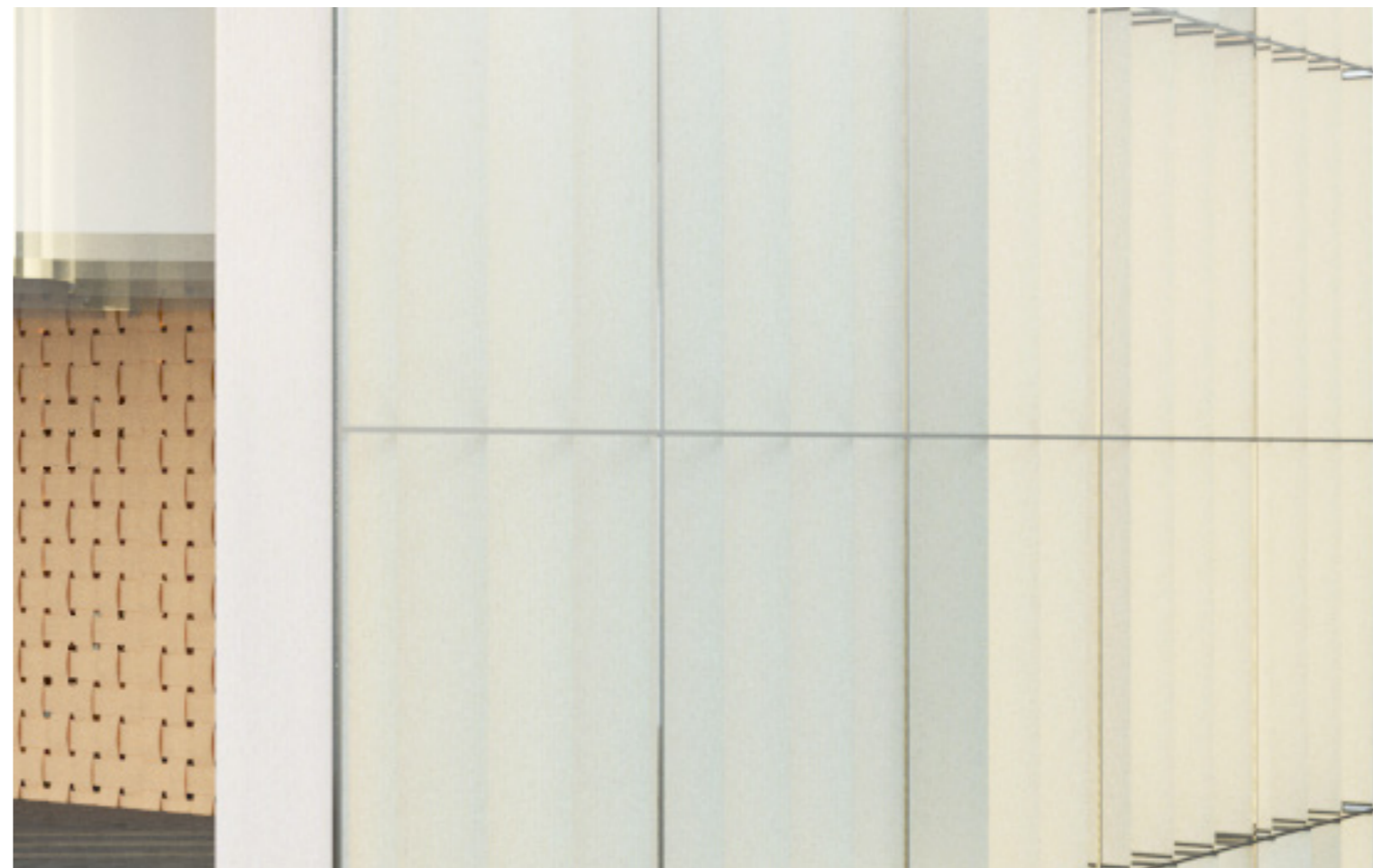
Rendering över fasaden som presenterar de roterande textilierna i luftspalten
