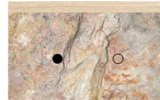
Öppningsbara Helmholtz absorberer i bänkar av sandsten, absorbererna är stängda till mellan 20 och 250 Hz.
