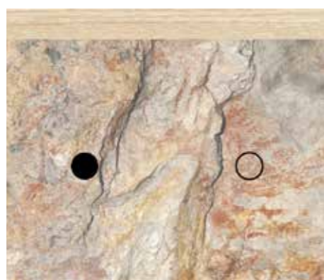
Stängbara Helmholtzabsorbenter inuti skiffersandstensbänkarna inställda att absorbera frekvenser under 250 Hz.
